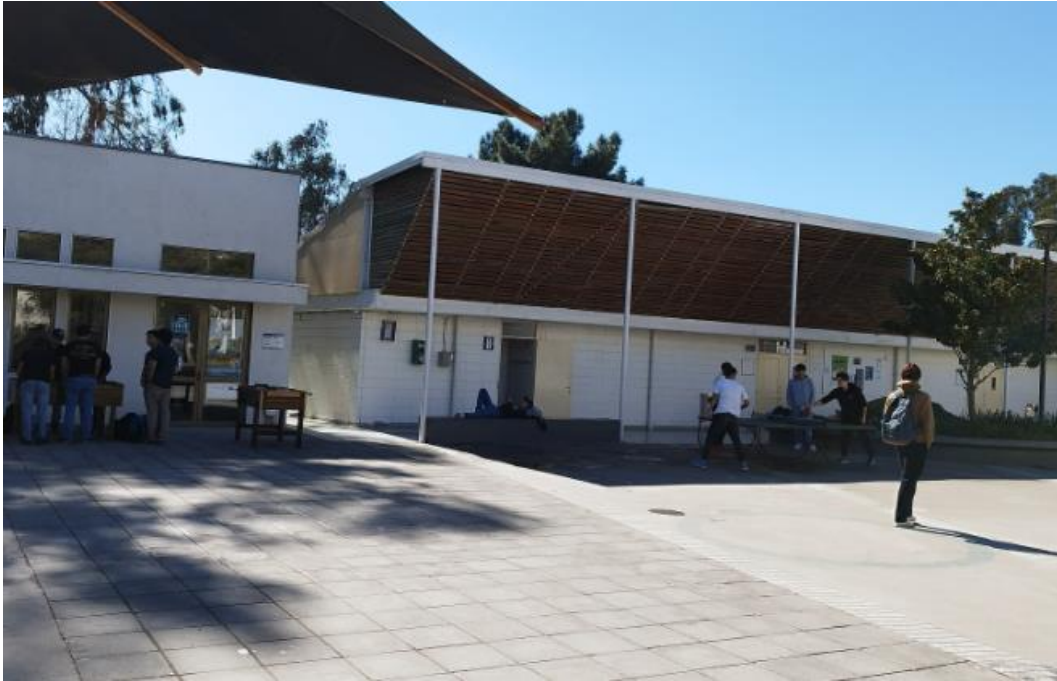
Fotografía N°13: Edificio H, aulas de clases
