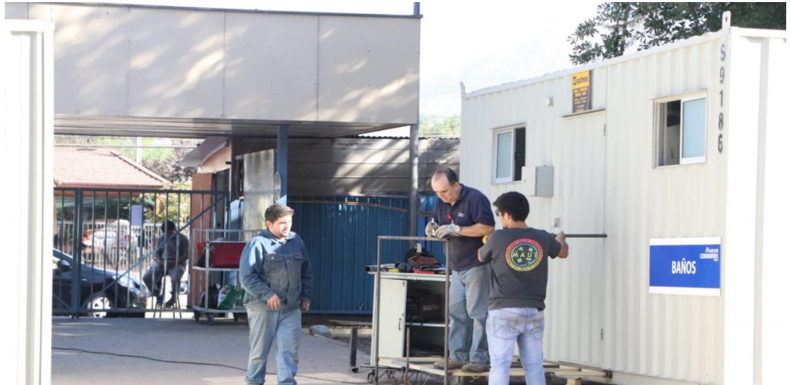
Figura 1-6 remodelación de baños unidad respiratoria
