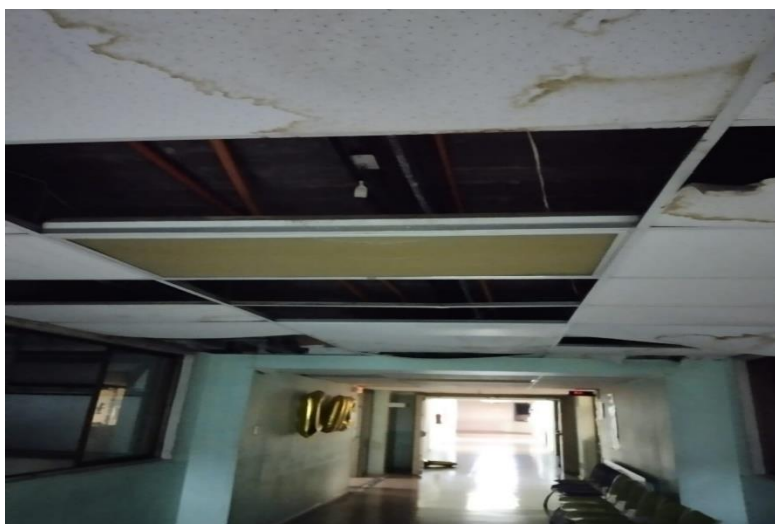
Figura 1-7 Remodelación de tercer piso hospital san Camilo
