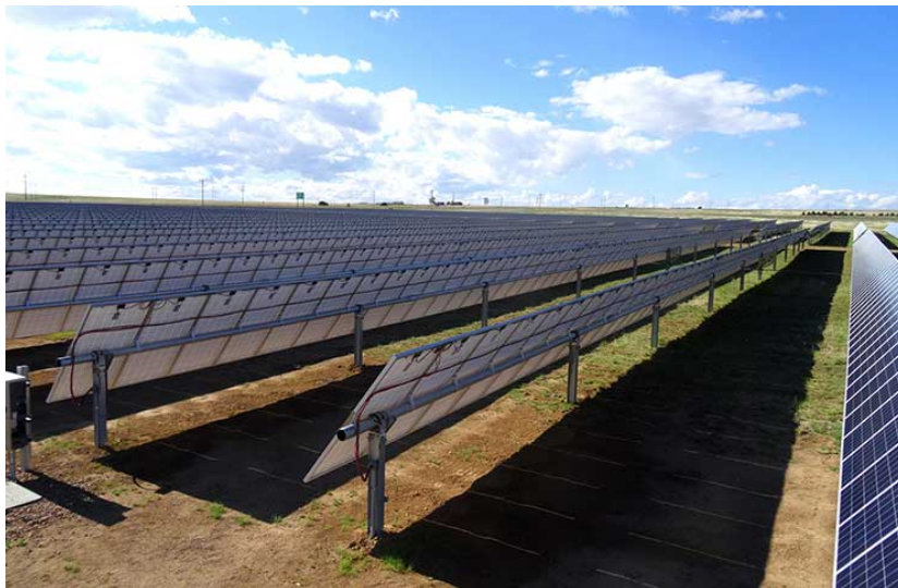
Figura 2.3: Instalación de seguidores solares de un eje Horizontal, acoplados en serie. Fuente: Array Technologies.
