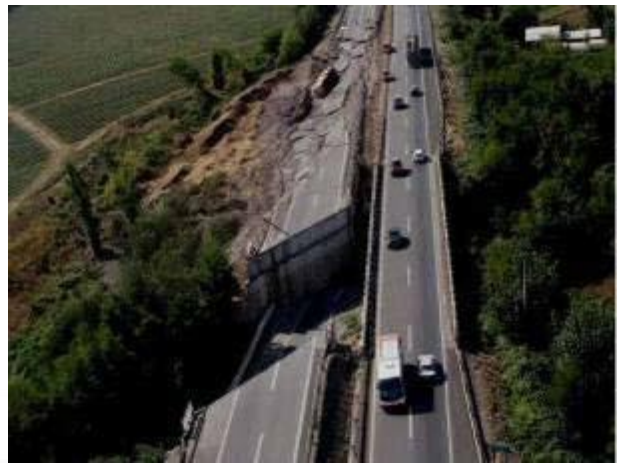
Figura 3 Sector Copihue: Grave daño por colapso tablero poniente PS FFCC y terraplén de acceso norte
