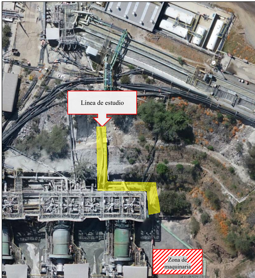
Figura 2: Vista satelital de las instalaciones de Minera Valle central en Requínoa, Región del Libertador General Bernardo O'Higgins. (Google earth, 2025)
