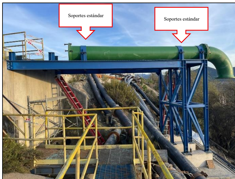
Figura 20: Estructura soporte de entrada al cajón de reparto.
