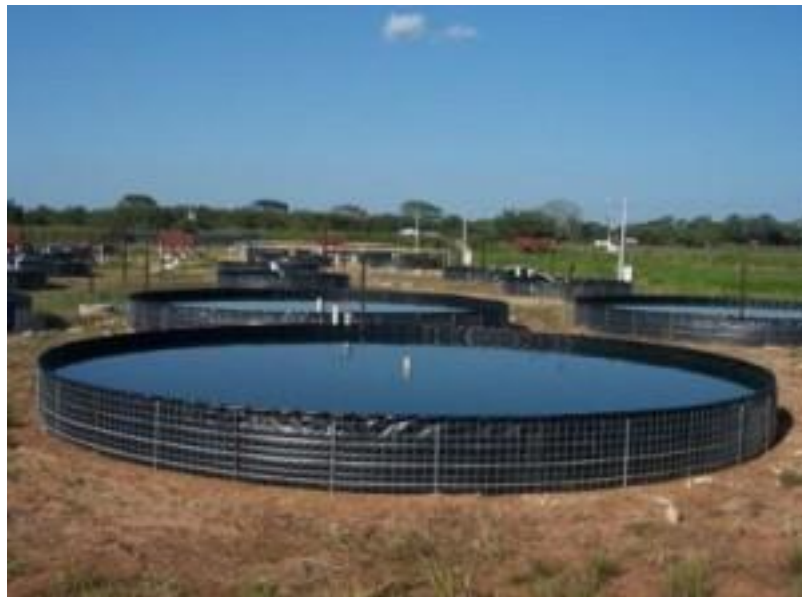
Figura 3-11: Reservorio de estanque (fuente: www.solostocks.com.co )
