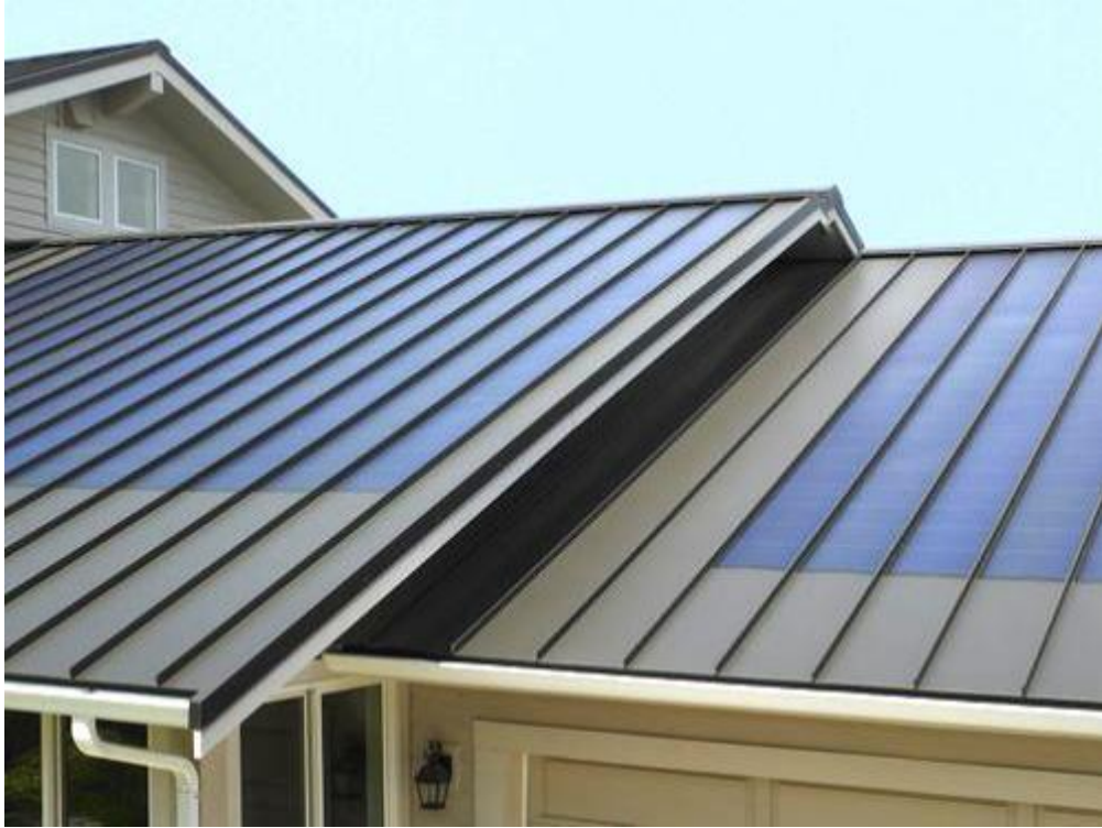
Figura 3-6: Techo de vivienda unifamiliar (fuente: construcción-materiales.adharaweb.com.ar)
