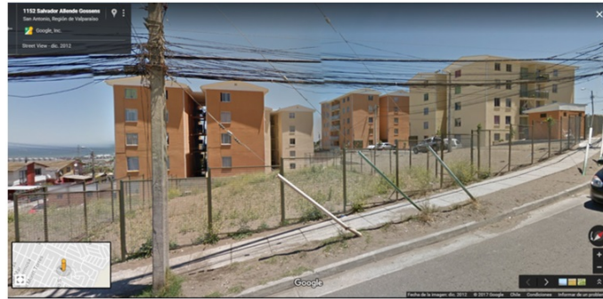
Figura 2.41: Vista hacia el edificio F y D. Fuente: Google Maps.
