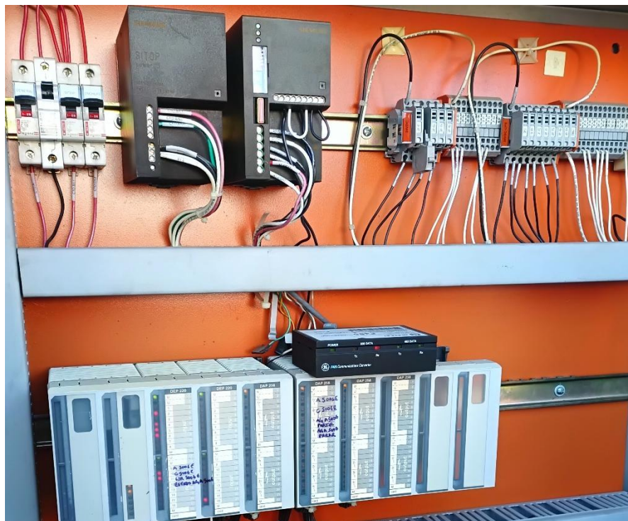
Figura 2-1. Configuración hardware actual PLC 9.
