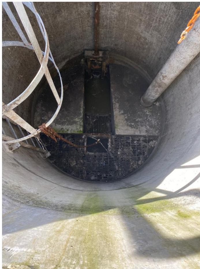
Figura 1-4: Foto en terreno de una cámara de rejas.
