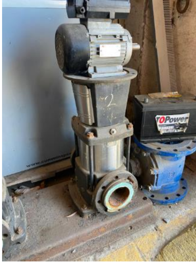
Figura 1-13: Bomba vertical una etapa.
