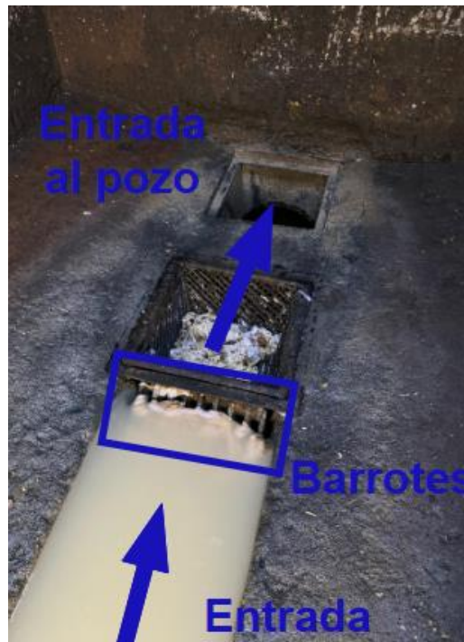
Figura 2-12: Barrotes de la cámara de rejillas.
