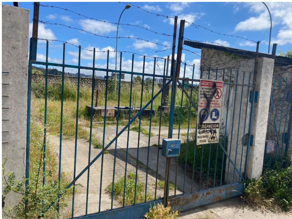
Figura 2-2: Entrada a la planta.
