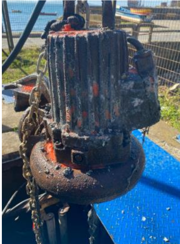
Figura 1-18: Bomba sumergible de planta elevadora de agua servidas.
