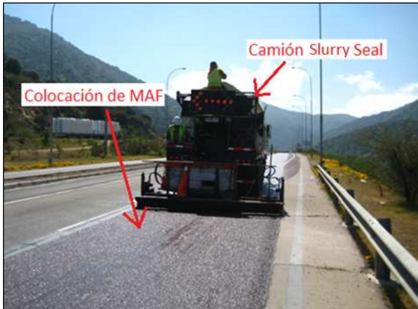
Figura 6-5: Aplicación de Microaglomerado asfáltico (MAF), Ruta 5. Fuente: Elaboración Propia.
