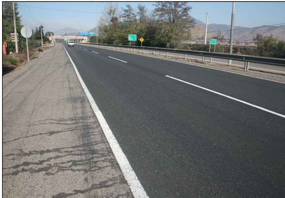
Figura 6-1: Pavimento al que se le ha aplicado un micro en frío, MAF. Ruta 5. Fuente: Elaboración Propia.
