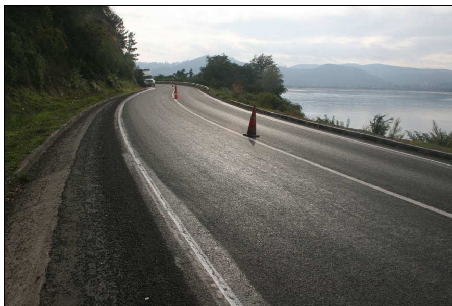
Figura 5-10: Material Grueso Desprendido de Microaglomerado en Frío. Conservación Ruta de la Madera, VIII Región. Fuente: Elaboración Propia.
