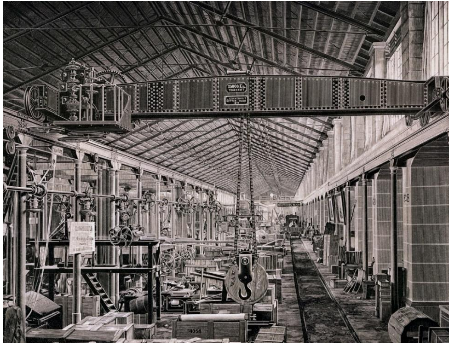
Figura 2.2. Puente grúa motorizado a vapor de 1875, producido por Stuckenholtz AG, Alemania.
