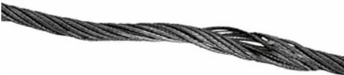
Figura 3.6. Inspección de cables. En el cable se ha formado una cesta como consecuencia de una torsión o giro violento. Fuente: ABUS Grúas.
