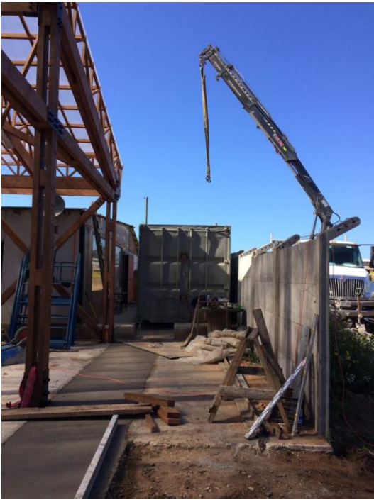
Fuente: Registro Constructora CCH
