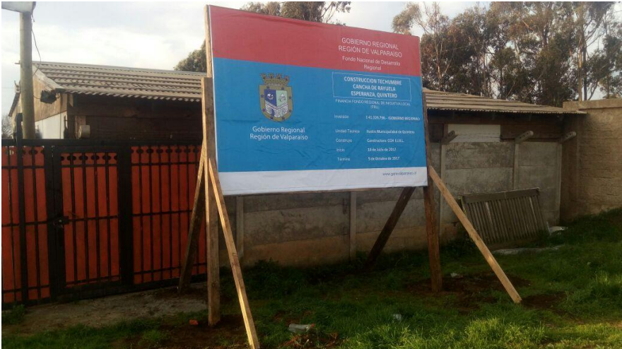
Fuente: Registro Constructora CCH.
