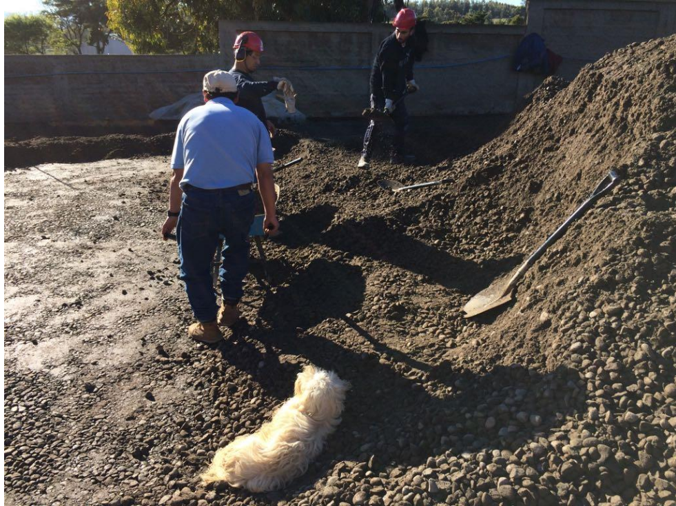
Figura 2-8. Relleno y compactado de hormigón
