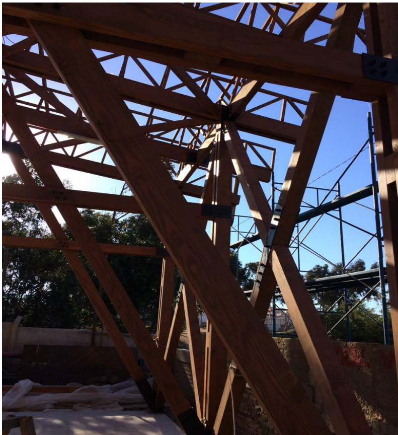
Fuente: Registro Constructora CCH
