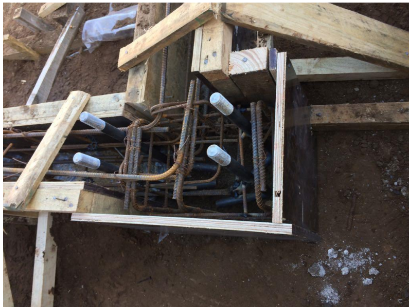
Figura 2-5. Colocación de moldajes
