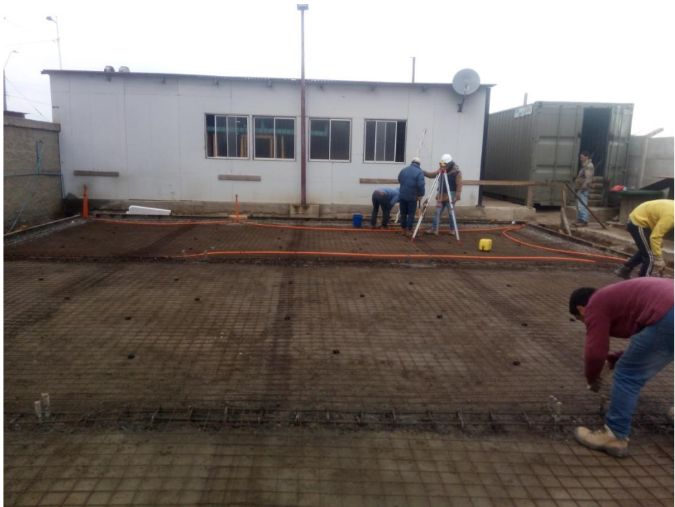
Fuente: Registro Constructora CCH
