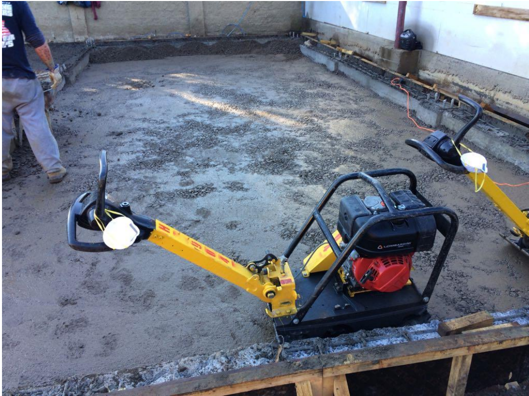
Fuente: Registro Constructora CCH Figura 2-11. Segunda capa de base estabilizada
