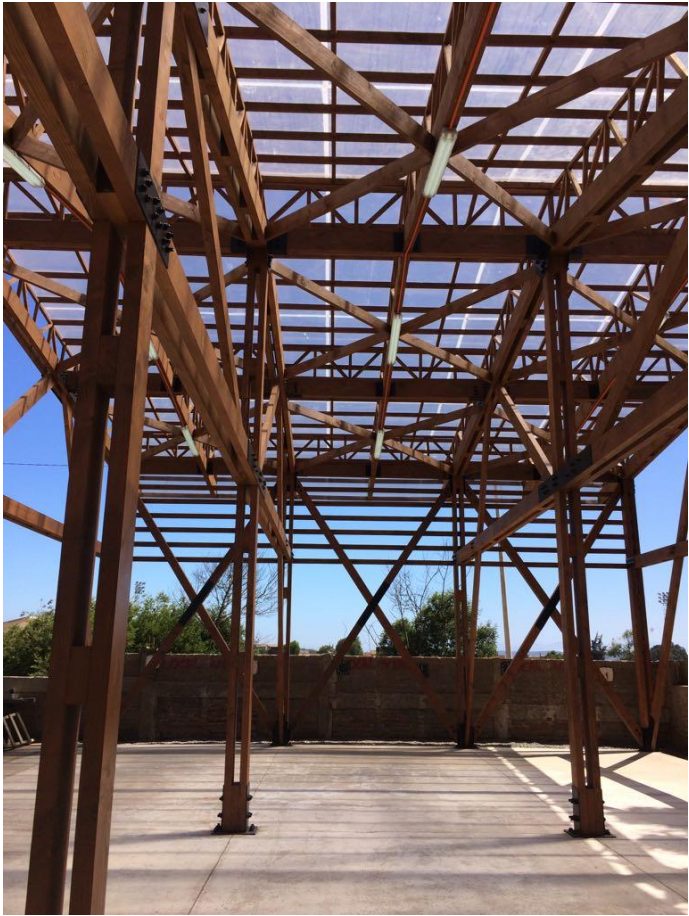
Fuente: Registro Constructora CCH
