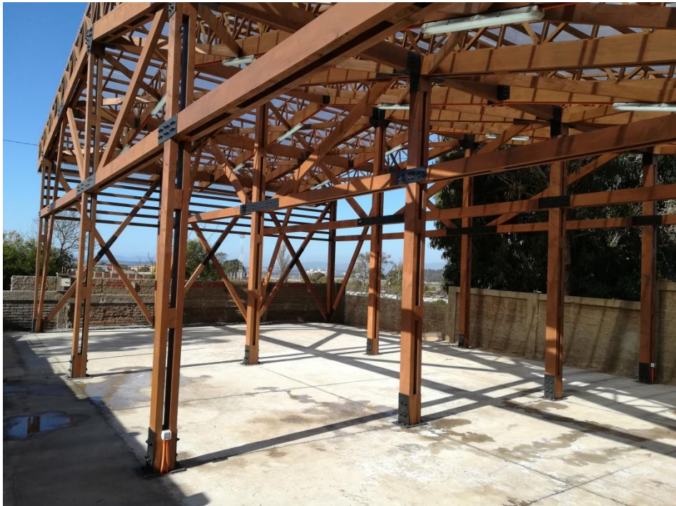
Fuente: Registro Constructora CCH
