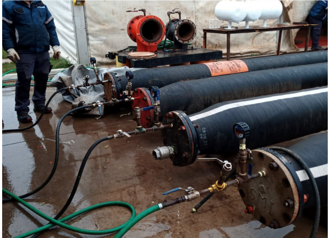
Ilustración 1-2 “Prueba hidrostática de flexibles en tierra”
