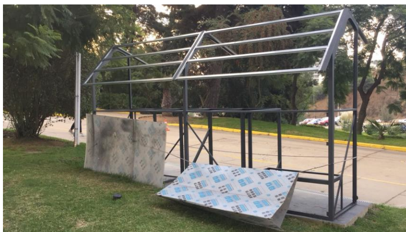
Figura 2-9. Construcción estructura metálica Punto Limpio Solar
