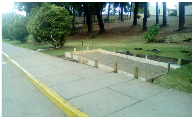
Figura 2-8. Construcción radier Punto Limpio Solar
