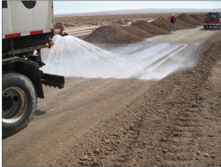
Figura 2-12: Riego para tratamiento de control de polvo.
