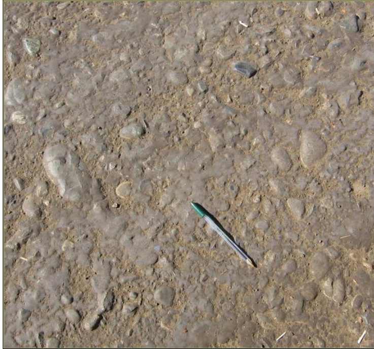
Figura 2-16: Fenómeno de cristalización superficial en carpeta de rodado (Halles, 2007).
