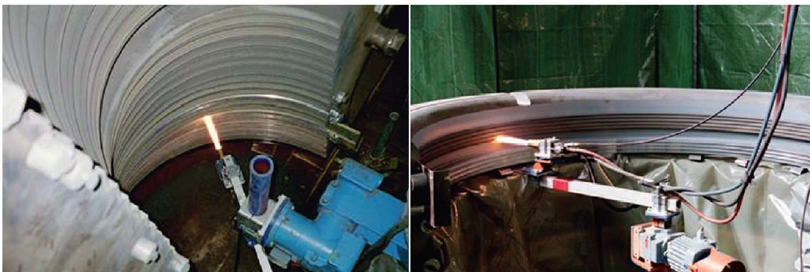
Ilustración 46 - Rociado del recubrimiento abrasible a turbina de vapor de 900MW
