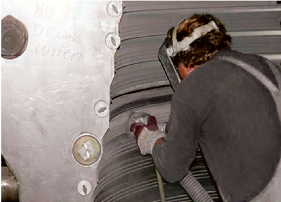
Ilustración 45 - Preparación previa a la aplicación del recubrimiento
