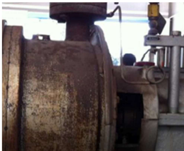
Ilustración 23 – Pilotaje manómetro de entrada vapor
