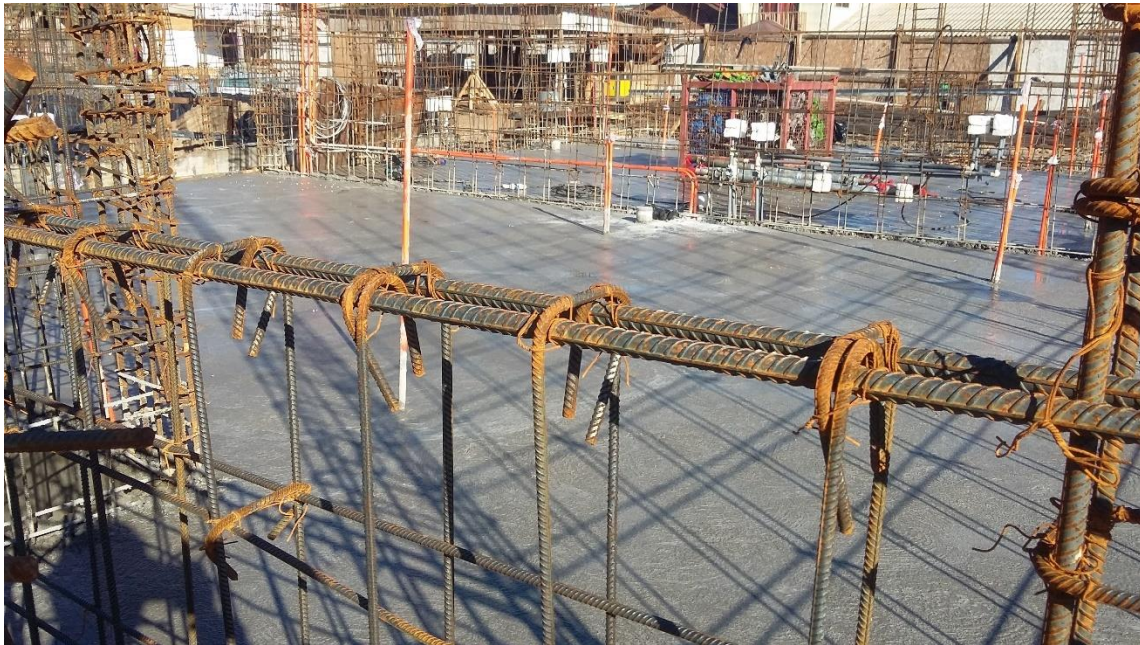
Figura 50. Hormigonado y vibrado de radier.
