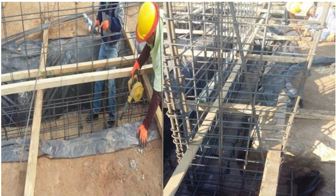
Figura 29. Enfierradura preparada, y encintado.
