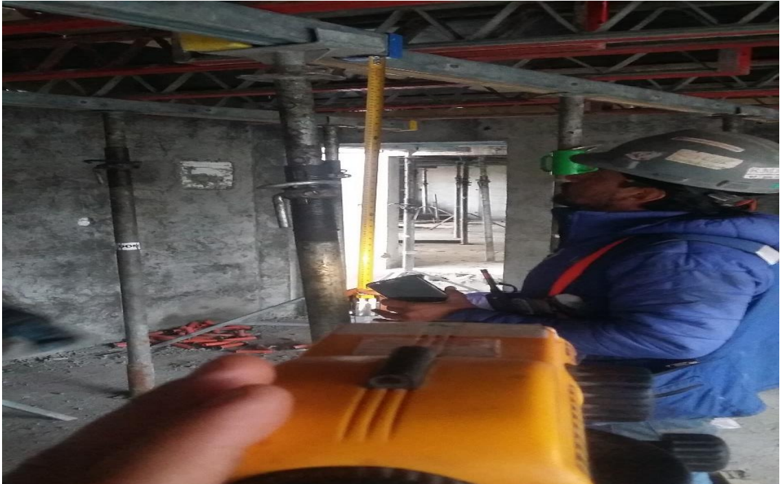
Figura 67. Cielo losa del primer piso.
