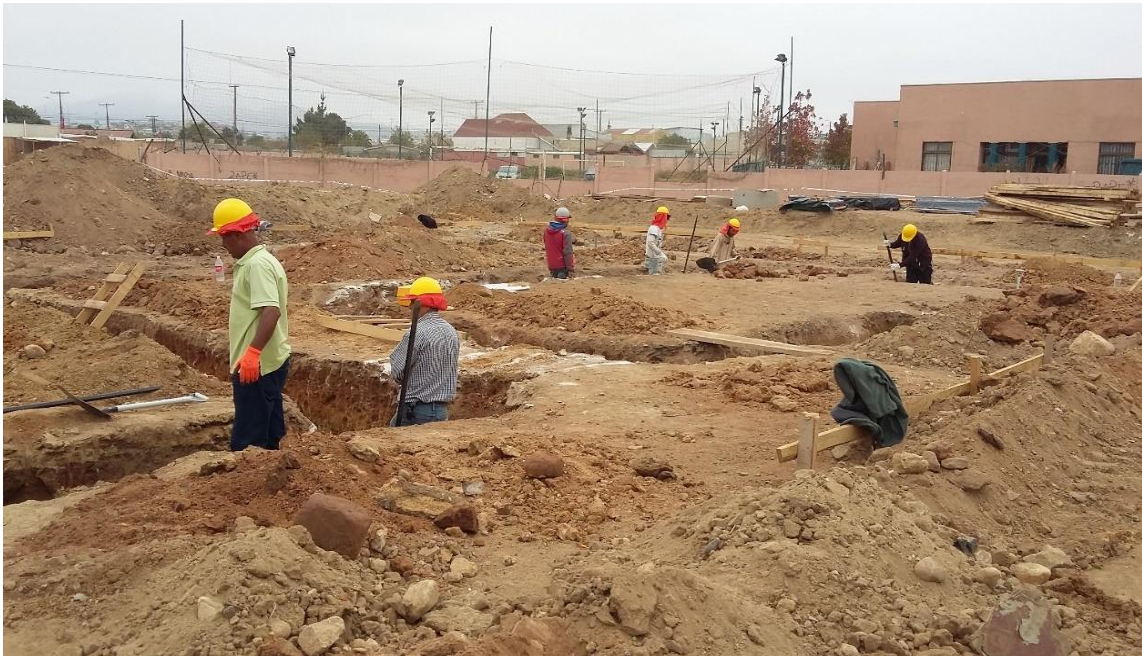
Figura 18. Perfilado de excavación en Cimientos del Edificio y canal.
