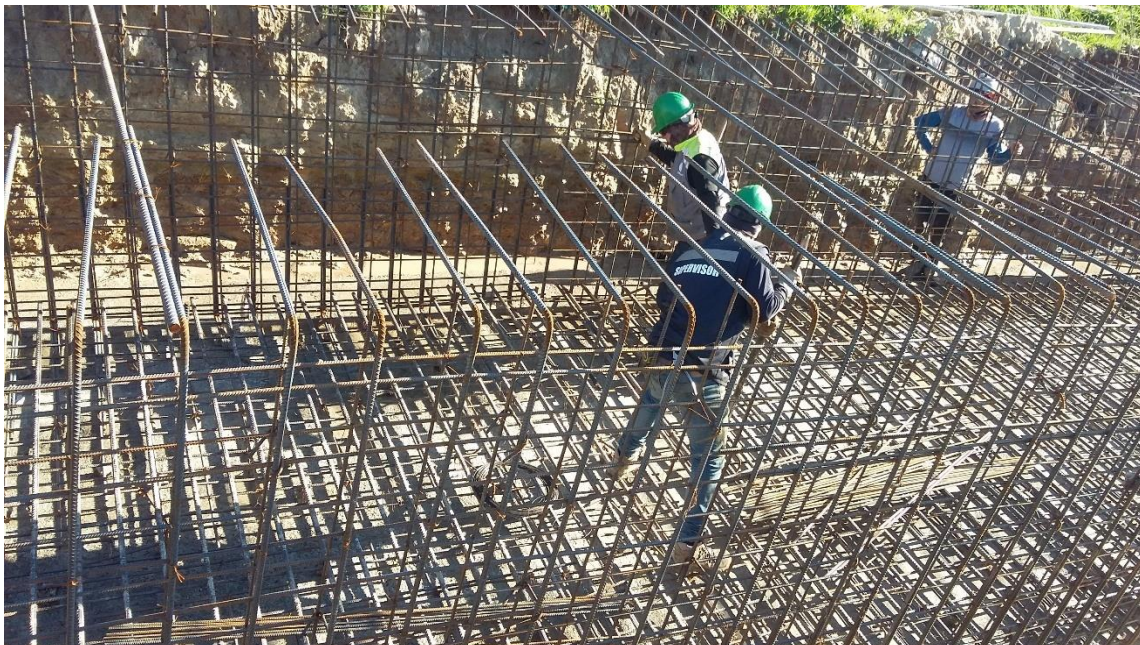
Figura 51. Ajustes en el encofrado de enfierradura.
