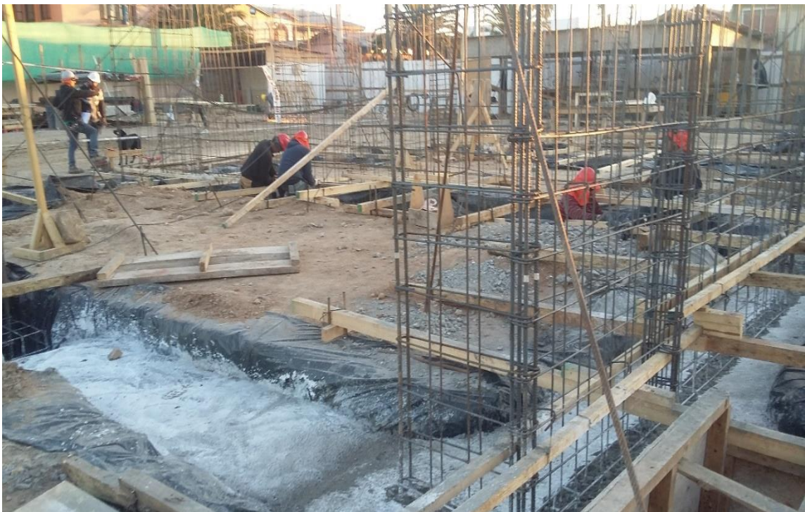
Figura 31. Recubrimiento con antisol.
