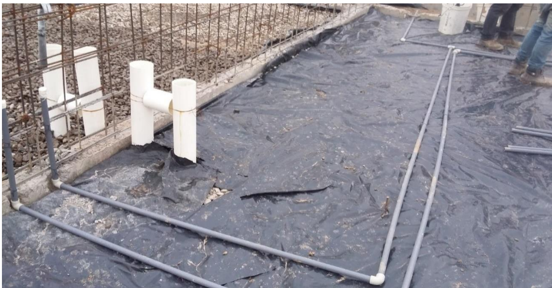
Figura 43. Recubrimiento de la parte interna de la torre A1.
