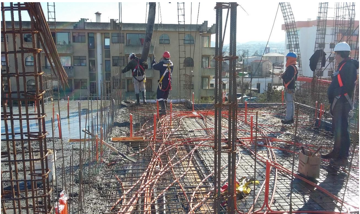
Figura 72. Hormigonado y vibrado de losa cielo segundo piso.
