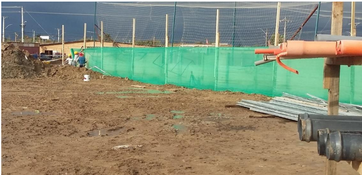
Figura 20. Faena anexa para el mejoramiento de la obra.
