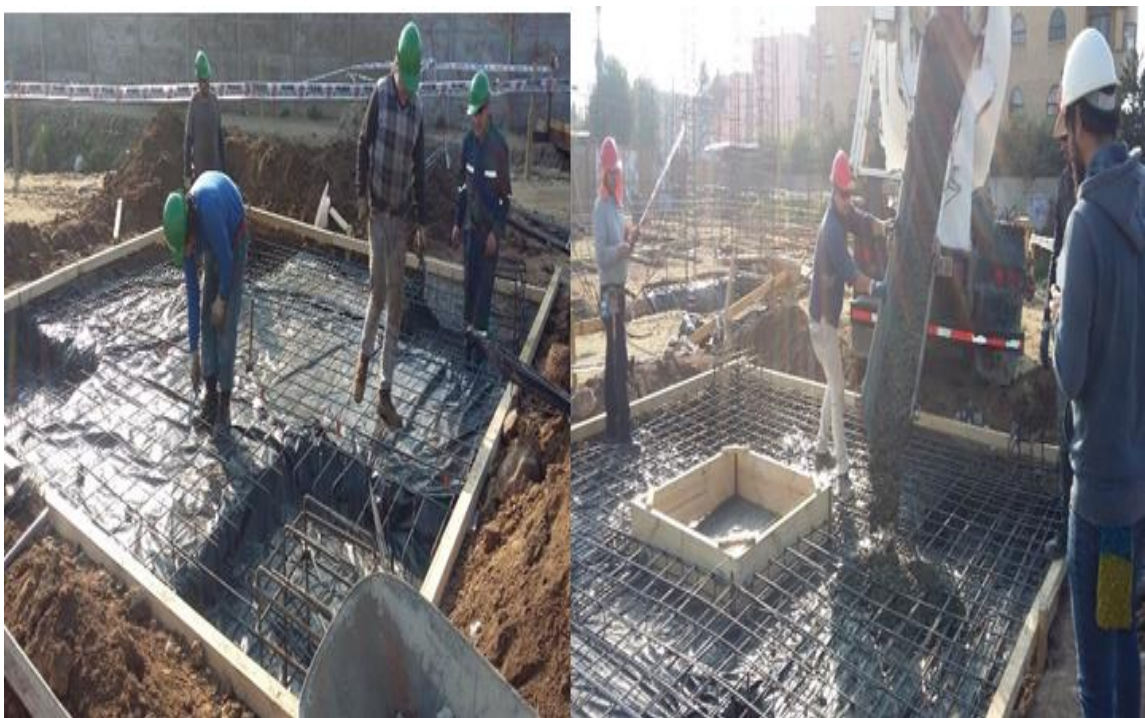
Figura 28. Radier para grúa torre.
