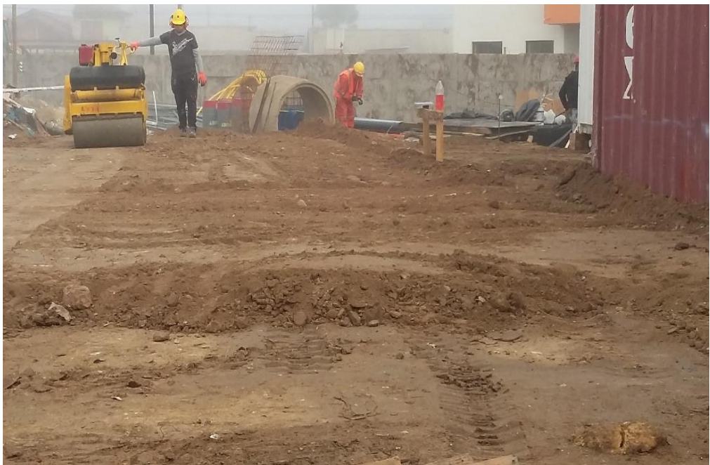
Figura 14.Compactación del terreno
