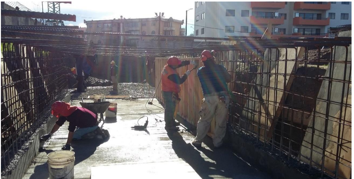
Figura 57. Modulación de los muros, del canal.
