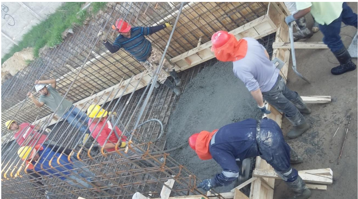
Figura 53. Hormigonado de radier.
