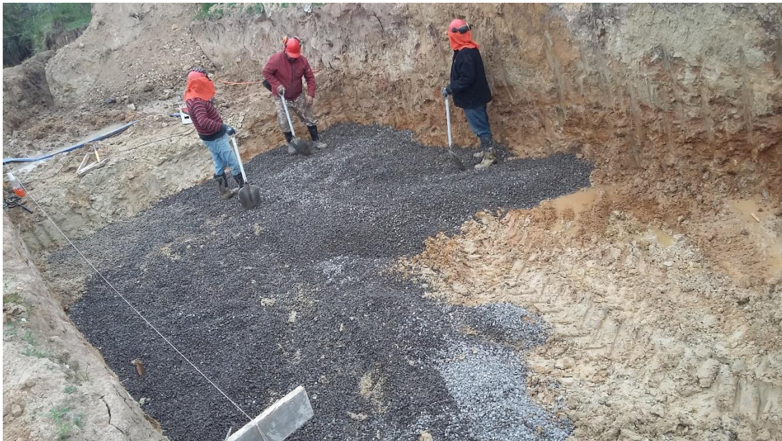
Figura 39. Estabilización del terreno en canal.
