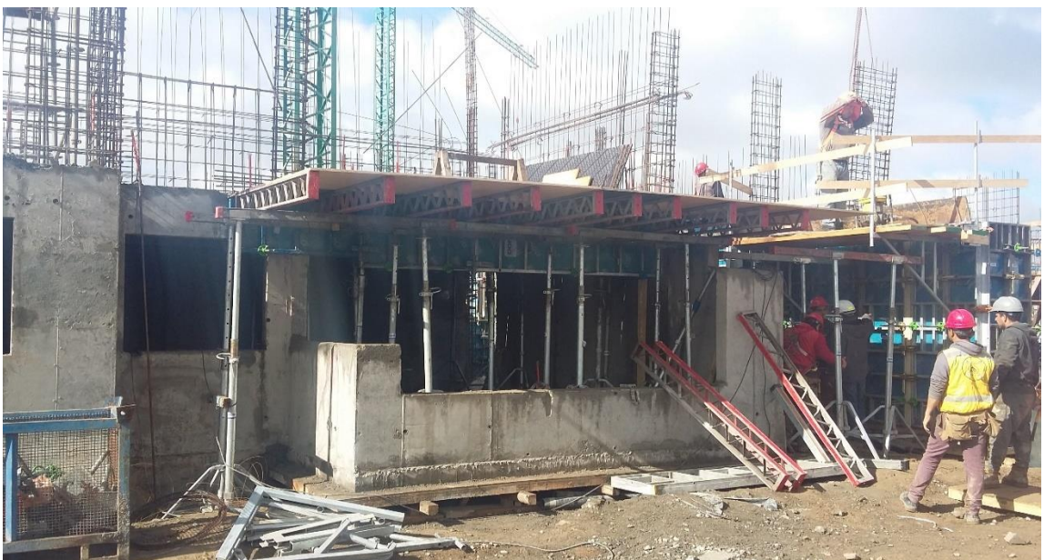
Figura 68. Construcción de aleros para terraza segundo piso.
