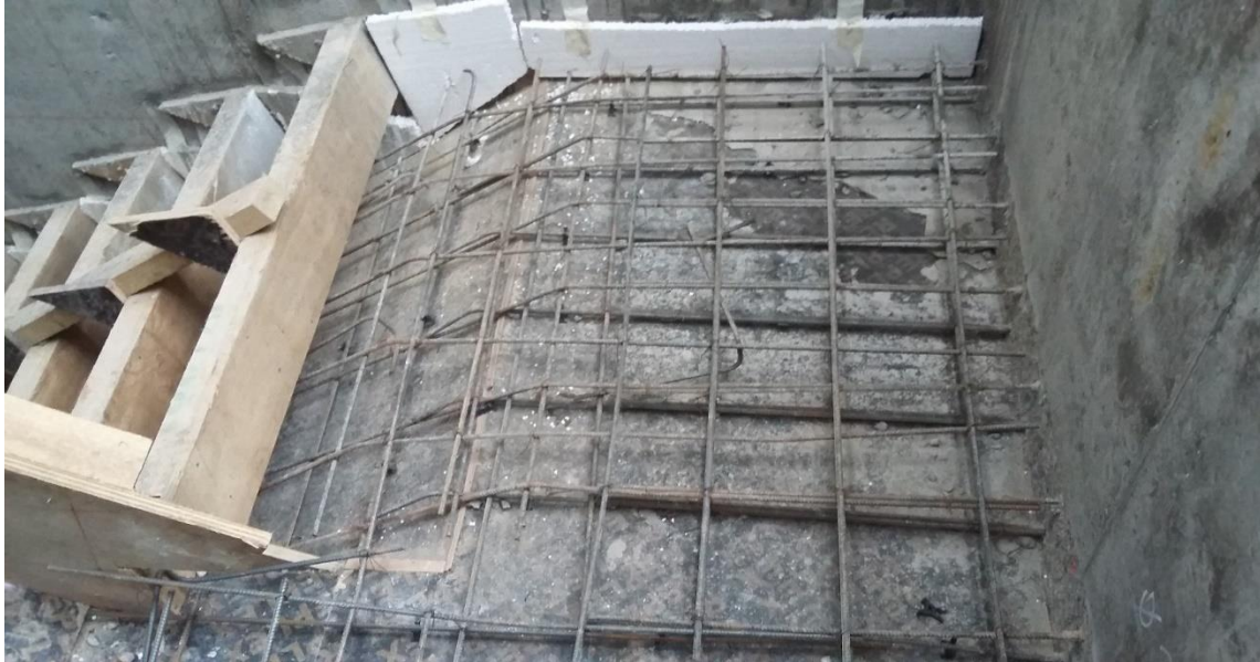
Figura 69. Confección de escala torre A1
