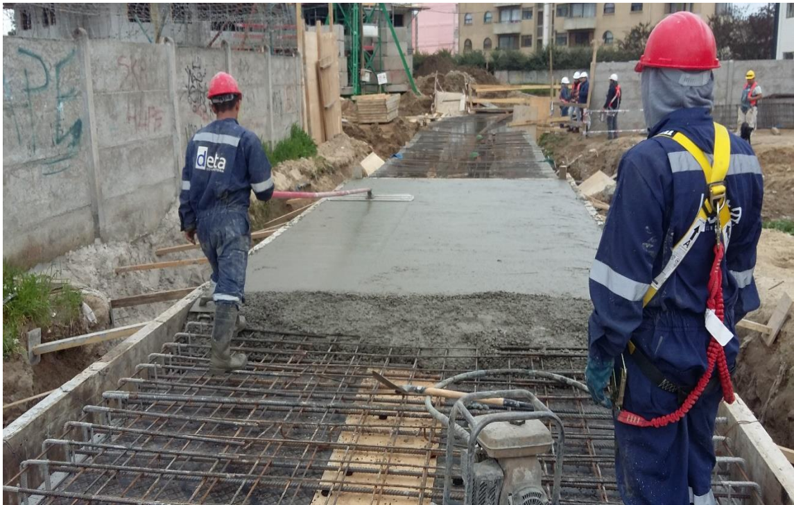
Figura 76. Hormigonado de la cuarta cara del canal.
