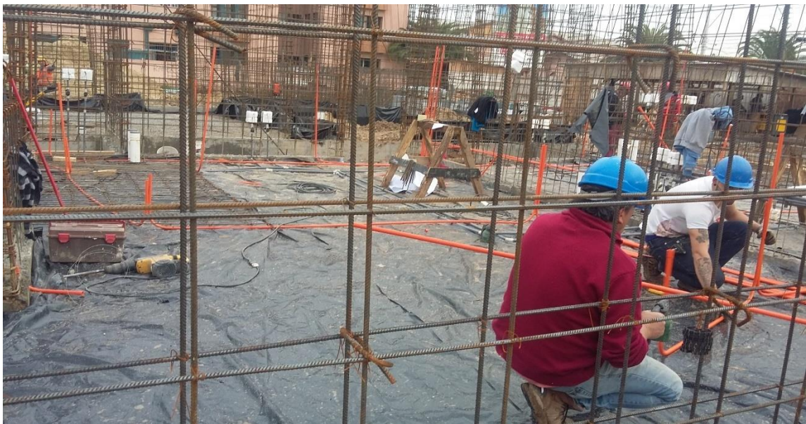
Figura 49. Primera y segunda malla de enfierradura.
