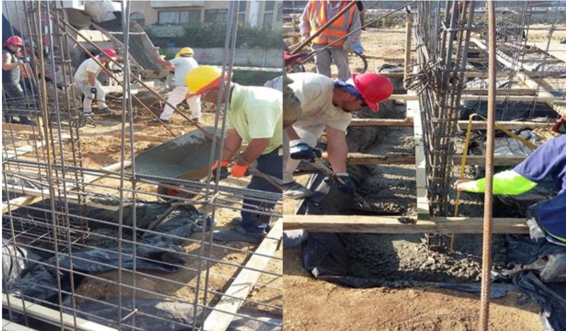
Figura 30. Limpieza y hormigonado.
