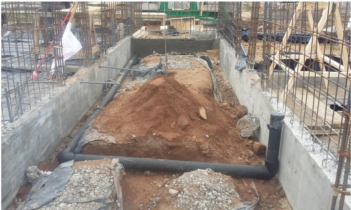
Figura 45. Instalación de tuberías de alcantarillado.
