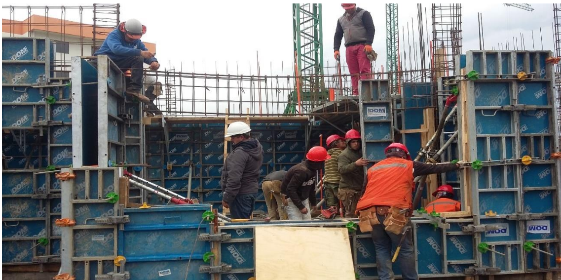
Figura 55. sistemas de encofrado de placas.
