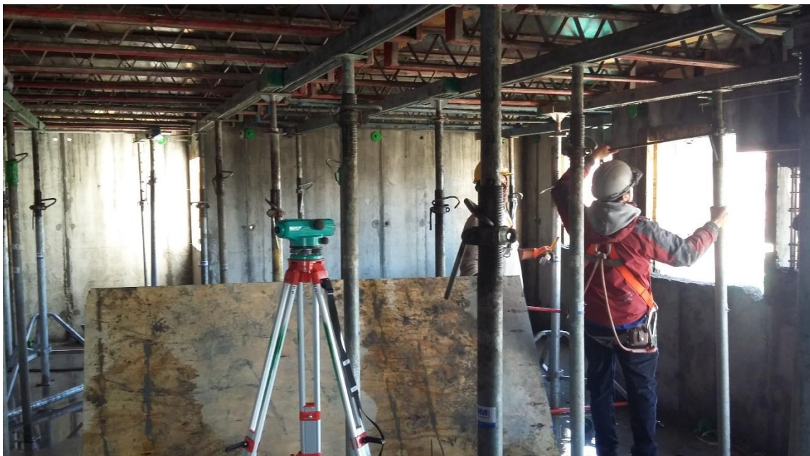
Figura 74. Rectificación de alturas, con nivel automático.
