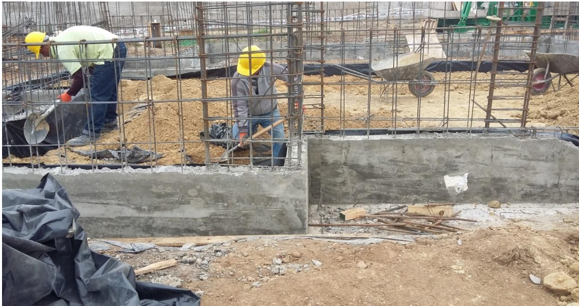
Figura 38. Nivel de piso natural interior torre A1.
