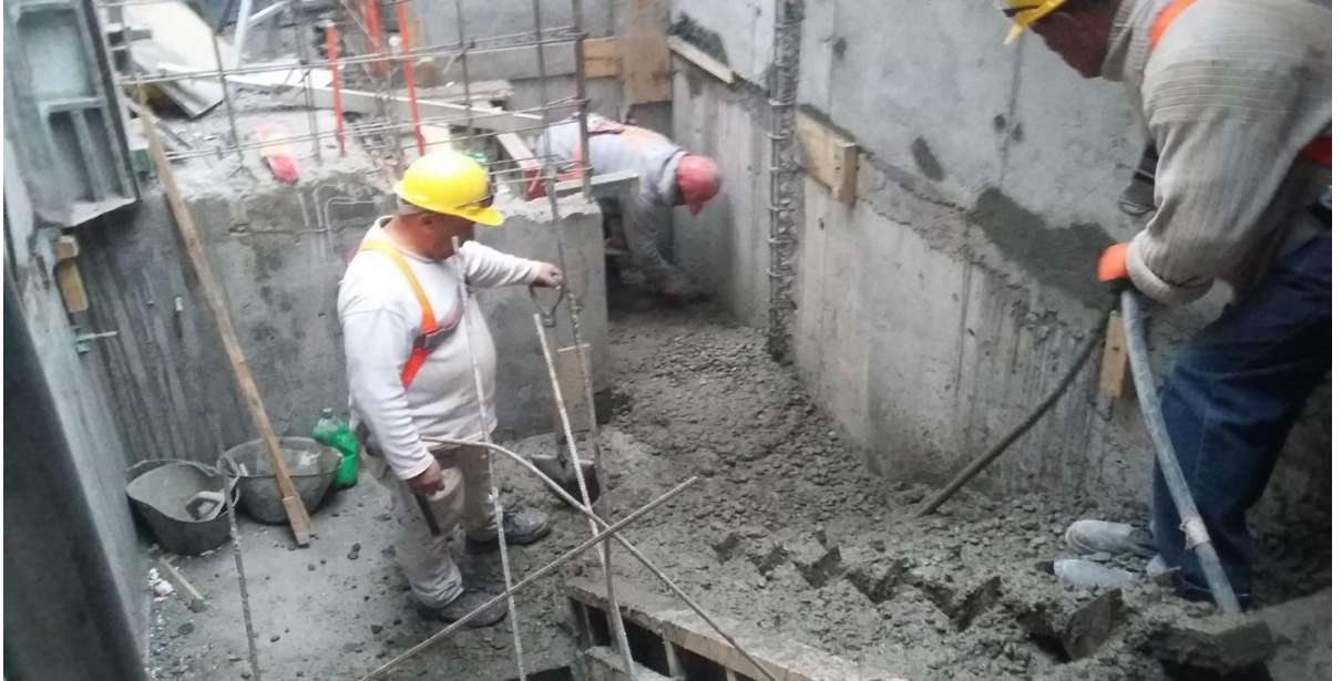
Figura 71. Hormigonado y vibrado de escalera.
