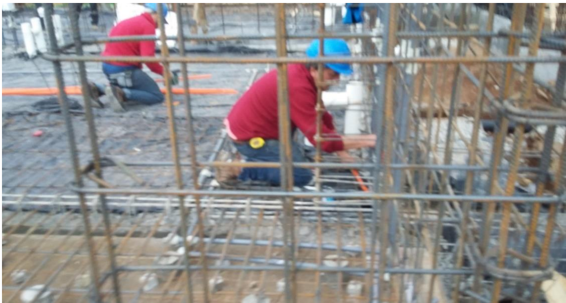
Figura 48. Instalación de ductos.
