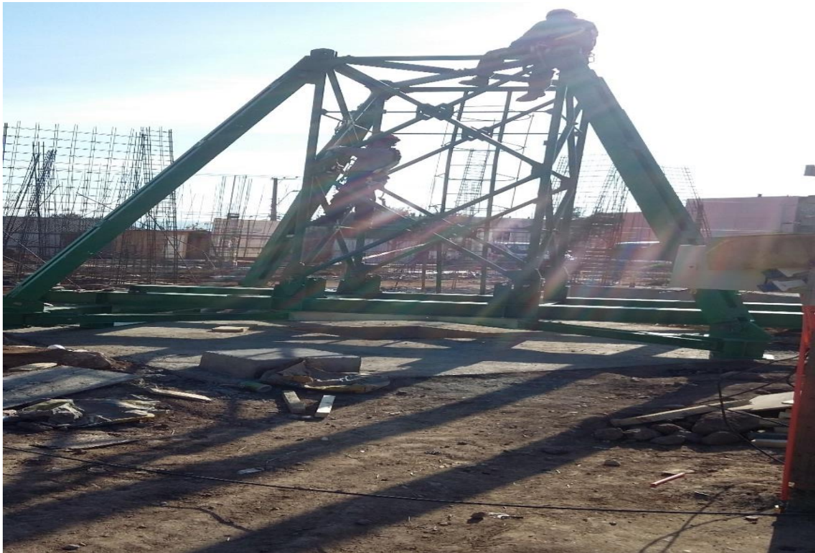
Figura 34. Equipo montador de grúa.
