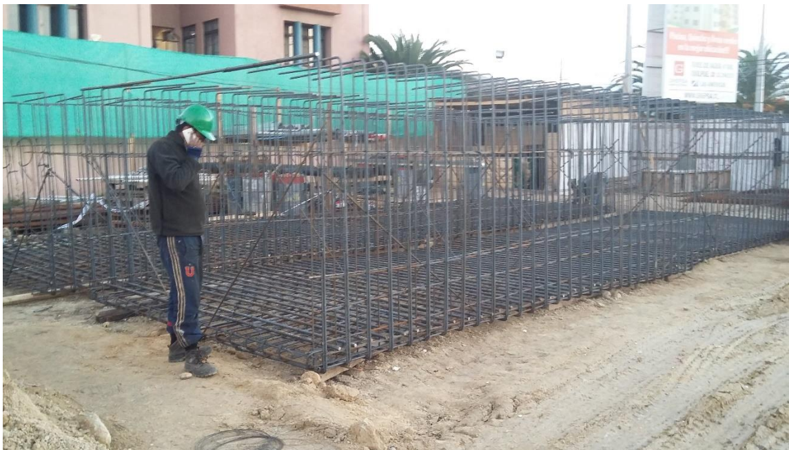
Figura 41. Encofrado para canal.
