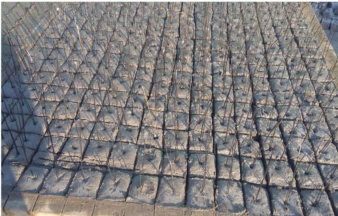
Figura 27. Se confeccionan cubos de hormigón pobre.
