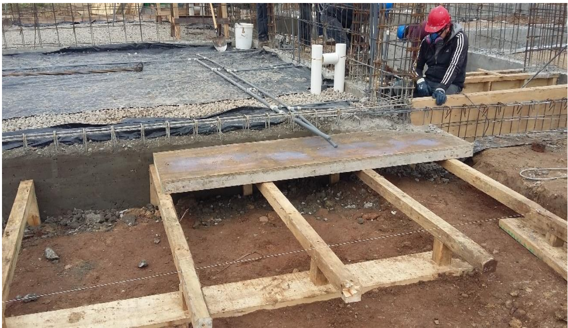
Figura 44. Moldaje de aleros de madera.
