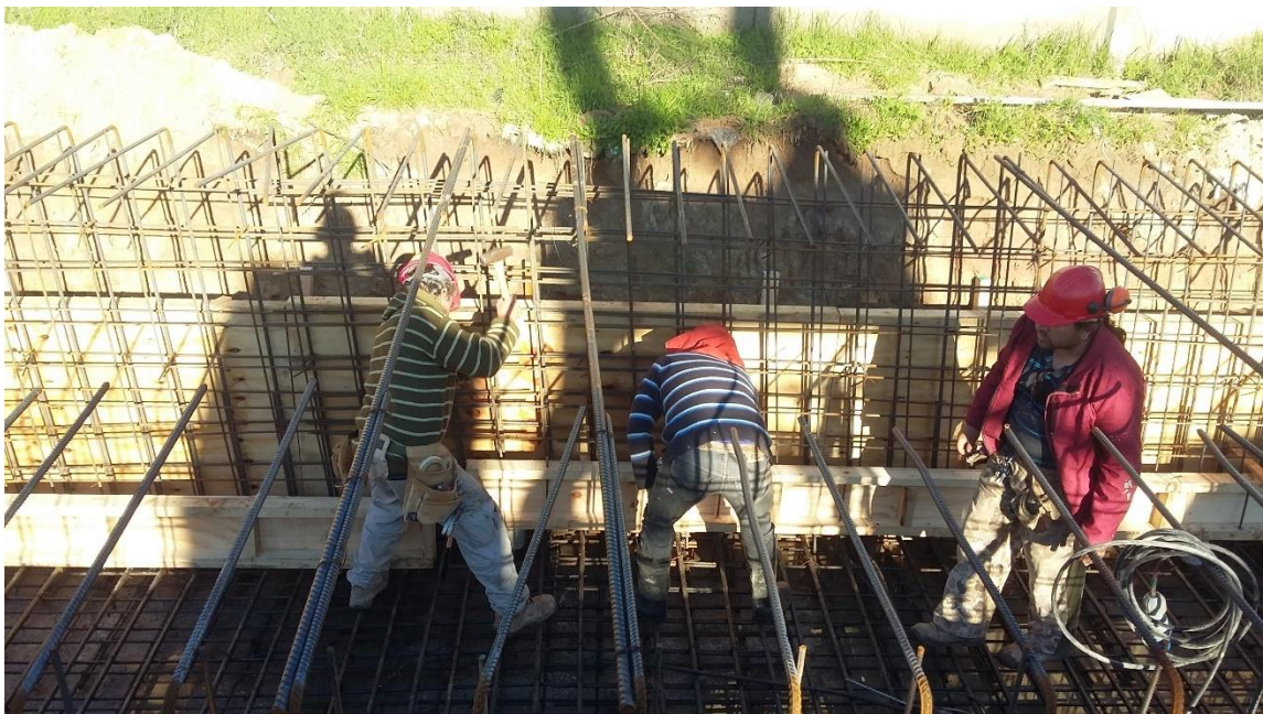
Figura 52. Moldajes de radier y rebalses.
