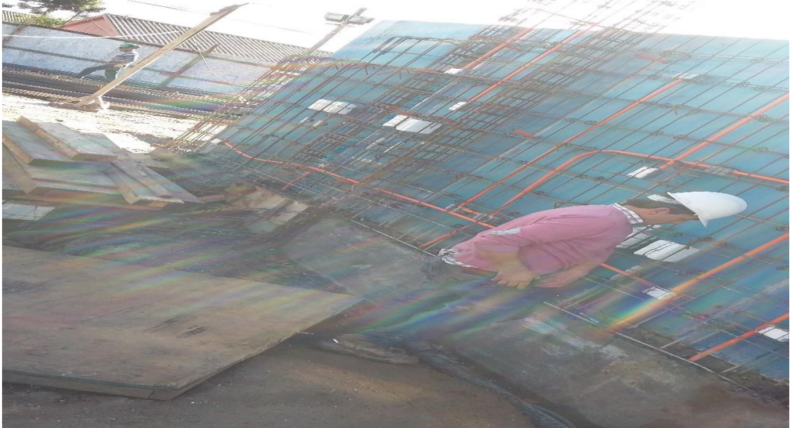
Figura 56. Revisión previa de ductos.
