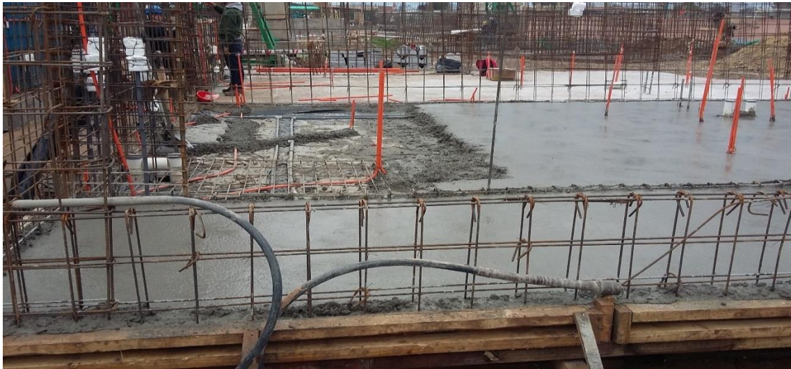
Figura 54. Continuación de hormigonado.
