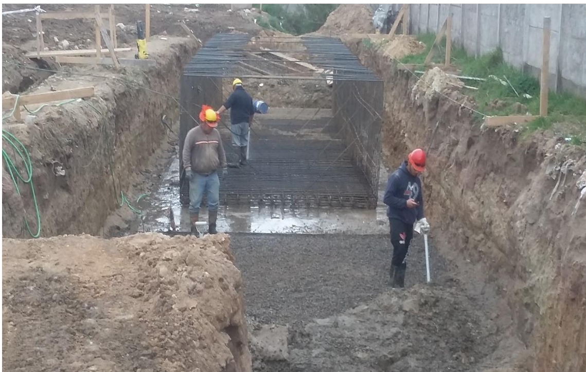
Figura 47. Instalación de malla de enfierradura.
