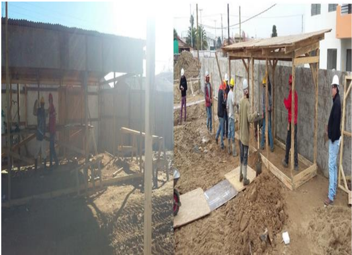
Figura 25.Faena anexa para el mejoramiento de la obra.
