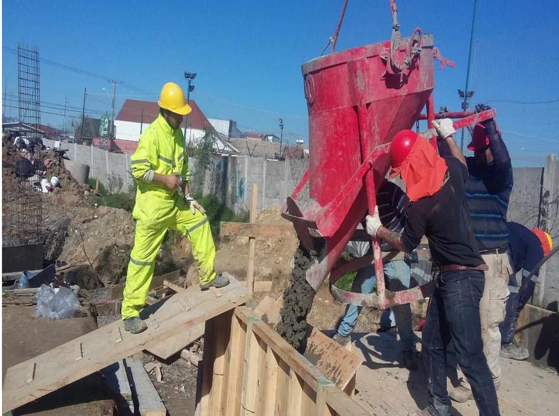
Figura 58. Hormigonado de los muros del canal.
