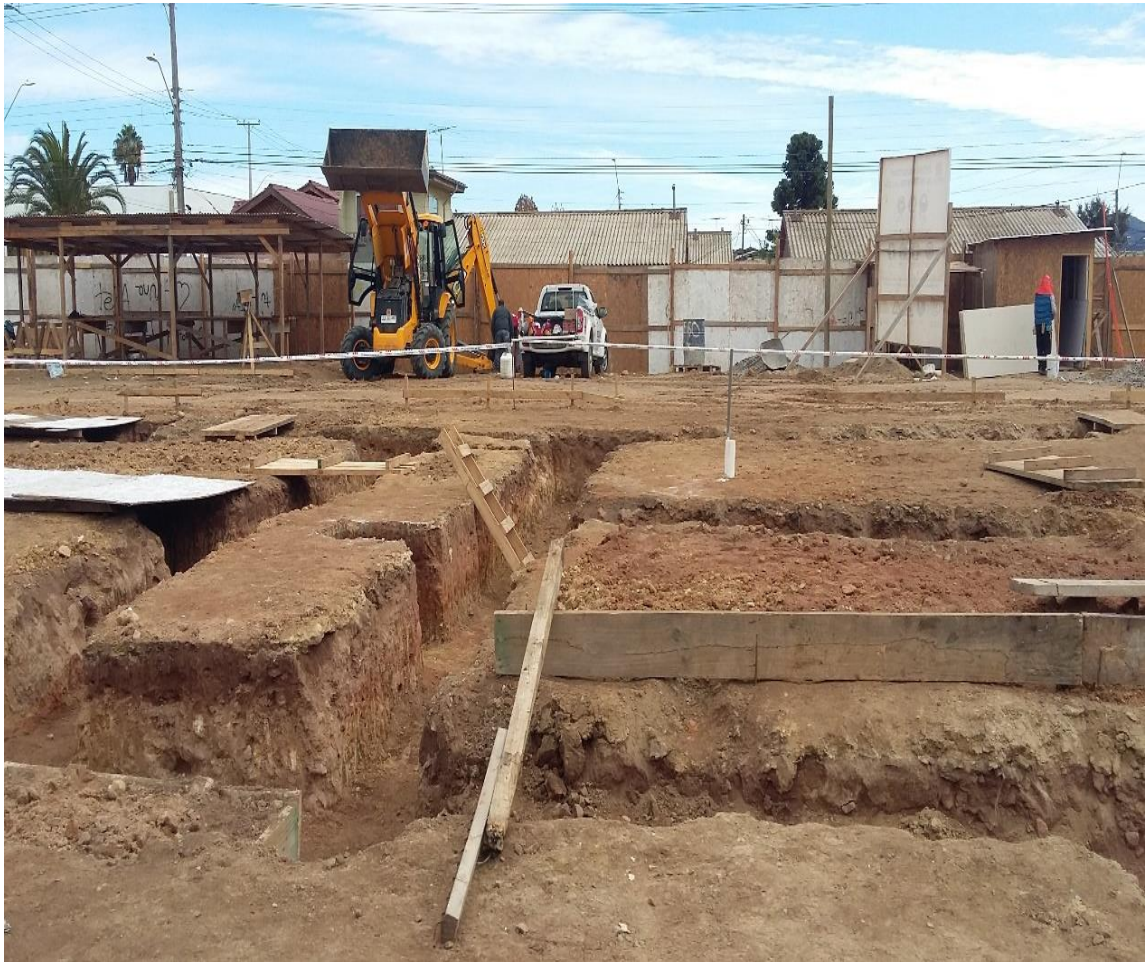
Figura 17. Excavación de Cimientos con retroexcavadora para Edificio.
