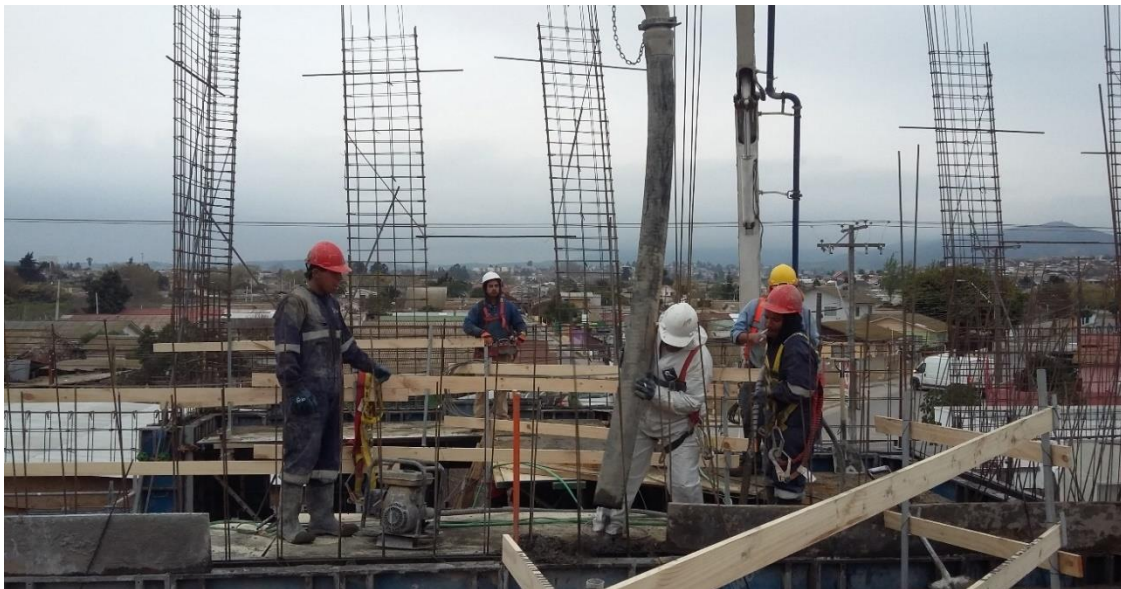
Figura 70. Especialistas en concreto.
