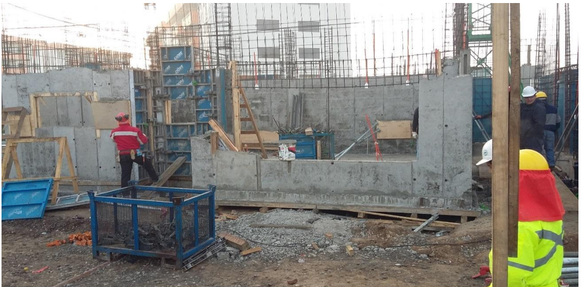
Figura 66. Descimbre de moldajes en muros.
