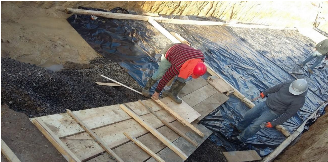
Figura 42. Instalación de polietileno en canal.
