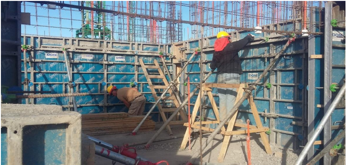
Figura 65. Limpieza de residuos.
