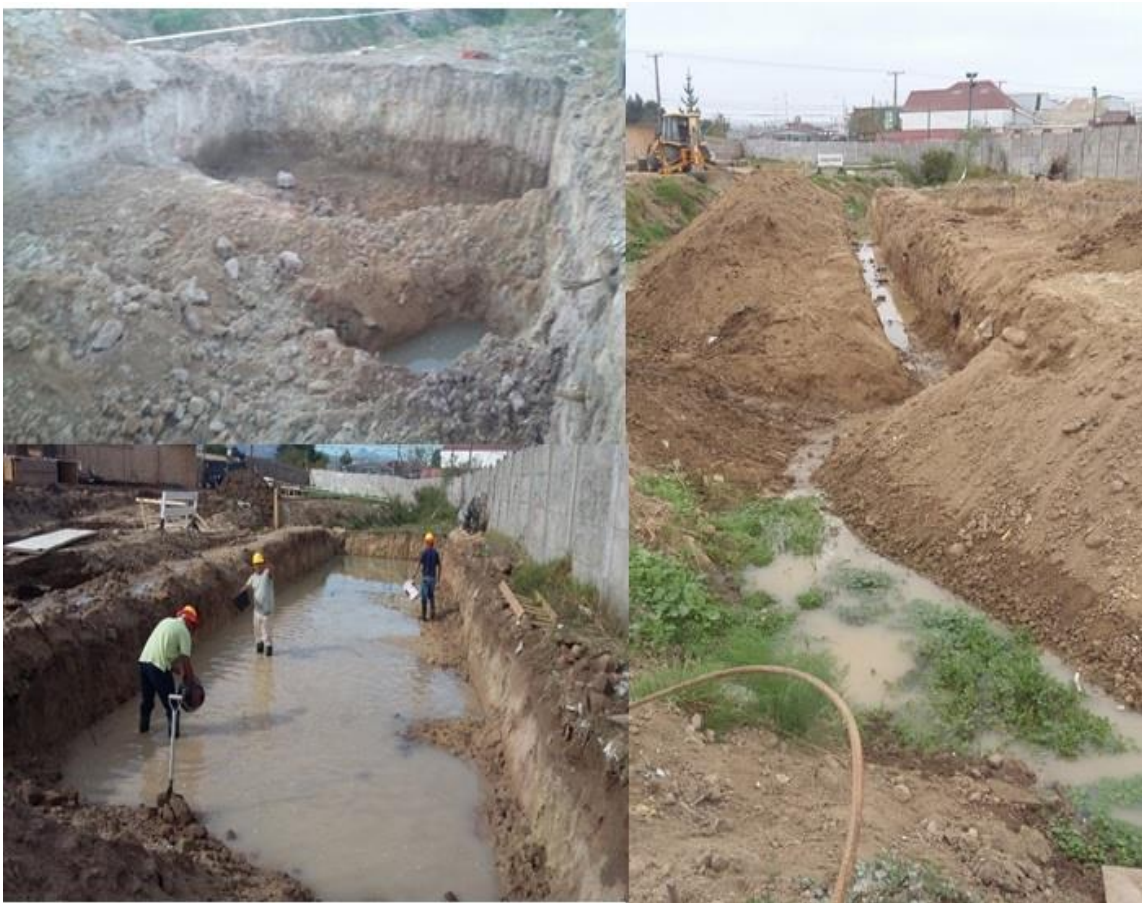
Figura 19. Excavación Cimientos con retroexcavadora en canal.
