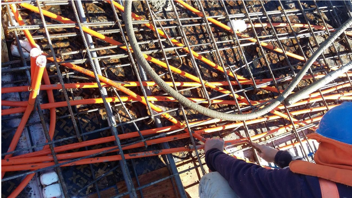
Figura 73. Eléctrico, en faena para optimizar tiempos.
