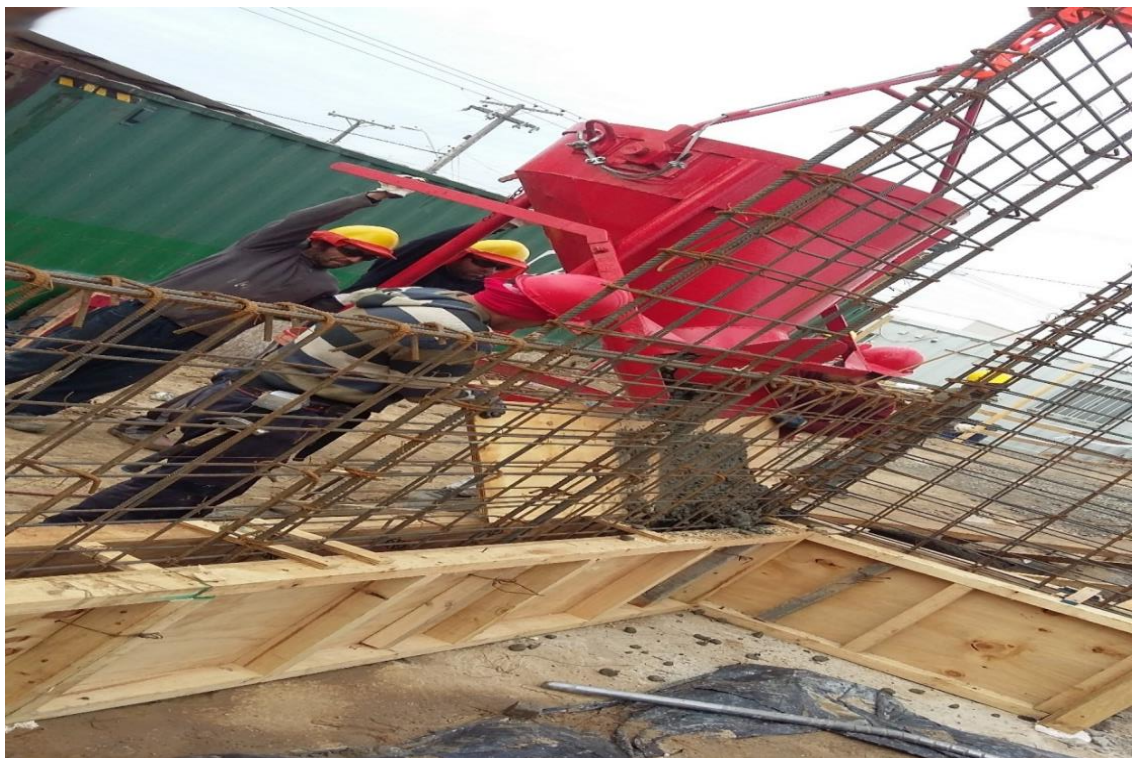
Figura 33. Hormigonado de fundación.
