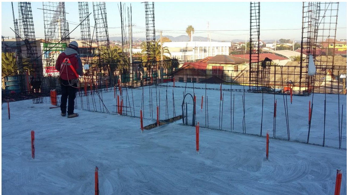
Figura 75. Aplicación de antisol.
