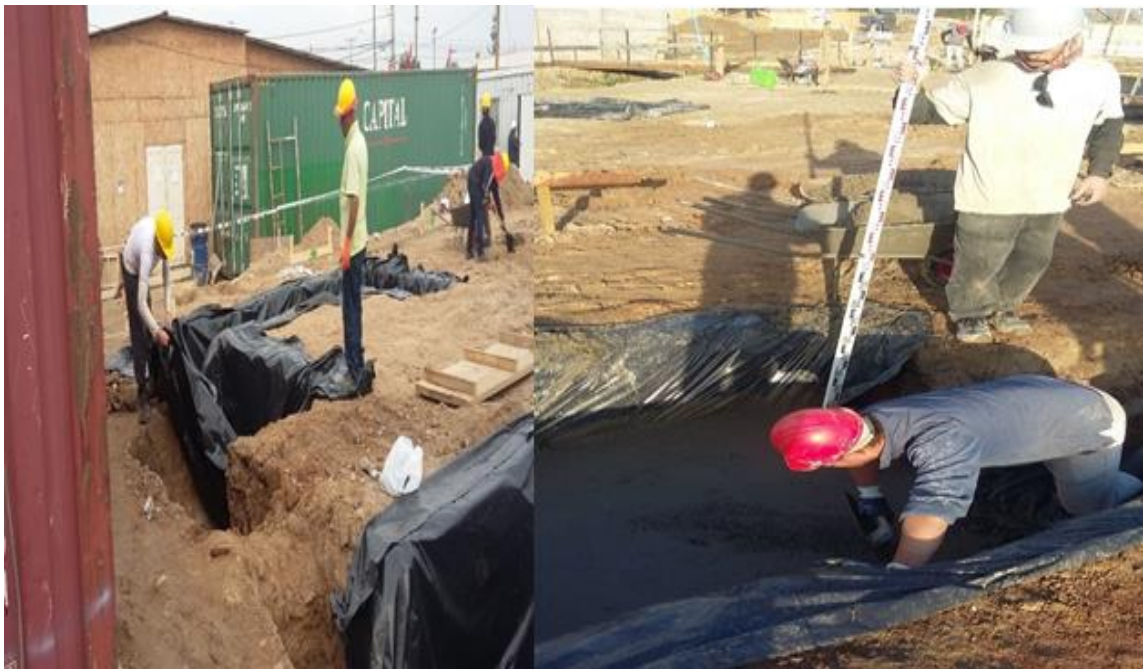
Figura 21.Instalaciones de polietileno, y comienzo del llenado del cimiento
