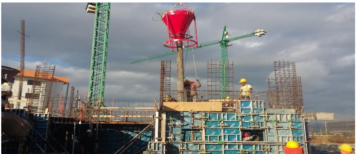
Figura 64. construcción de plataformas, para trabajo en alturas.
