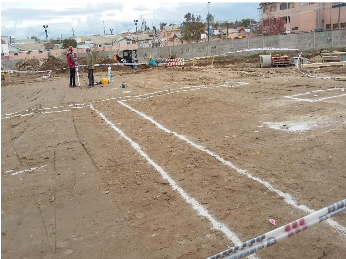
Figura 16. Trazado de edificio y canal.
