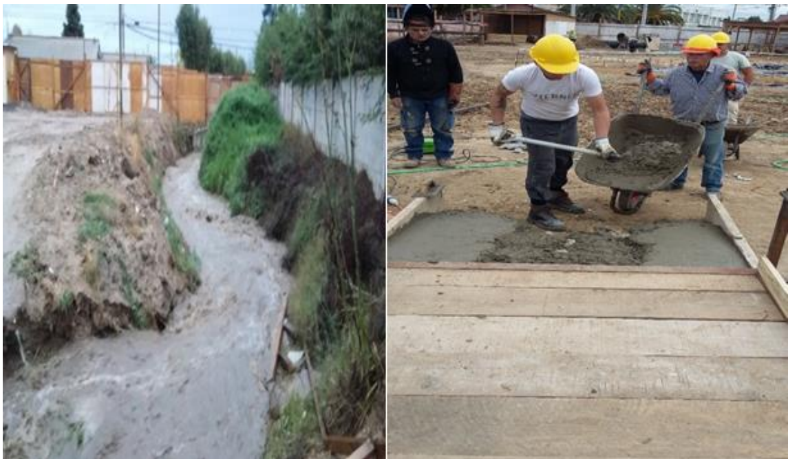
Figura 24. Faena anexa para el mejoramiento de la obra.
