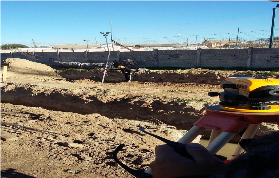
Figura 36. Excavación del canal.
