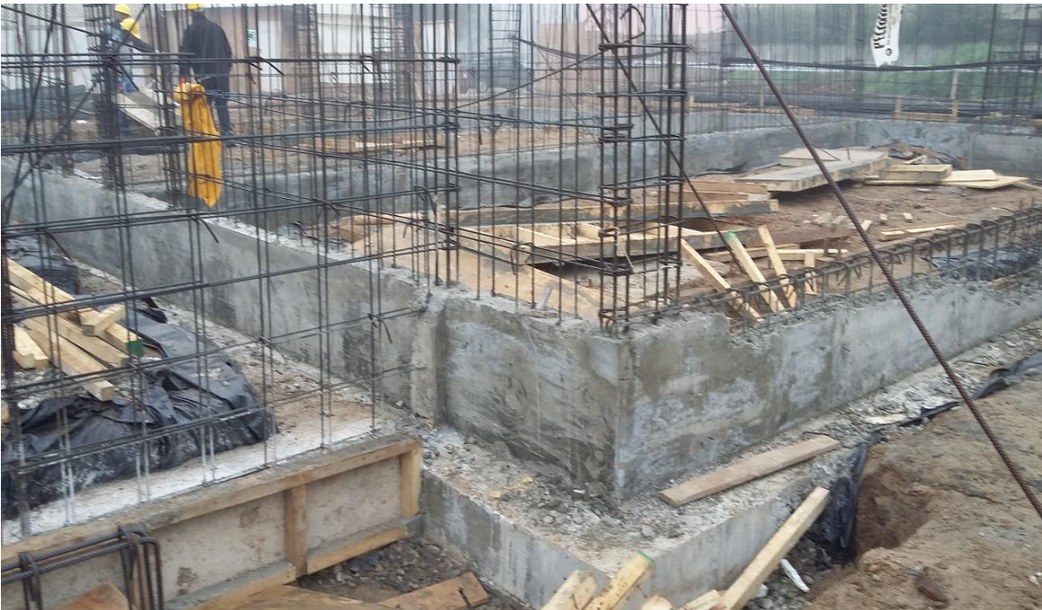
Figura 37. Descimbre de moldajes.
