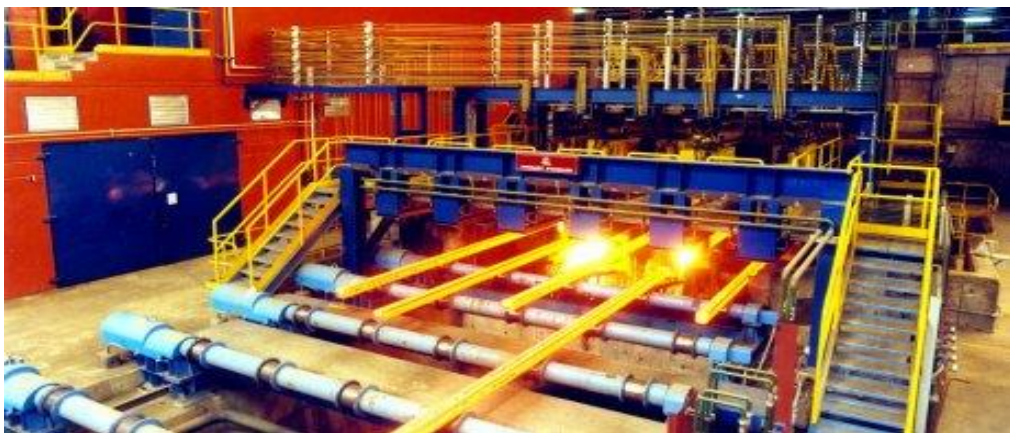
Figura 2.1. Dependencias de colada continua, sección carro de corte palanquillas, Huachipato. Fuente Metalia Chile, 2015.
