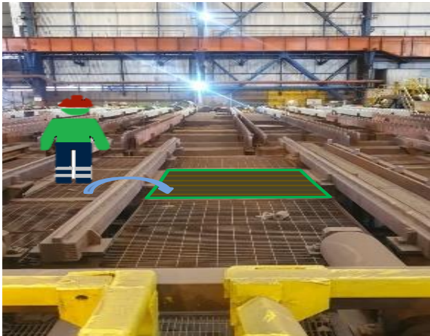
Figura 2.4. Análisis de accidente, estructura que cede. Fuente propia.
