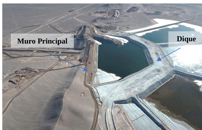
Figura 2.7: Muro principal, dique y laguna Operacional del tranque de relaves. Fuente: Conpax.
