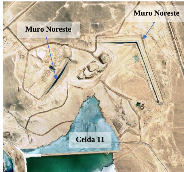
Figura 2.8: Muros Noreste y Noroeste, y celda 11 del Tranque de relaves de Minera Spence.
