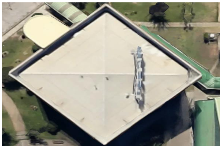
Imagen 3-2. Foto satelital de la cubierta existente.
