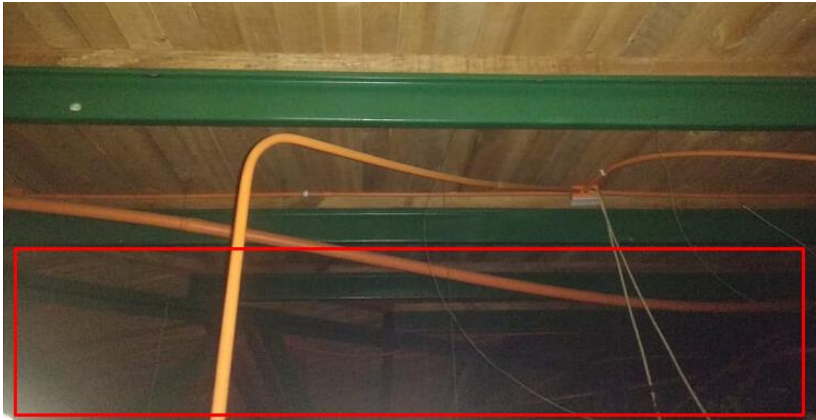
Imagen 3-4. Foto cerchas existente.
