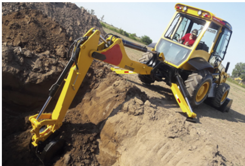
Figura 3.11: Movimiento de excavación de trinchera. [6]
