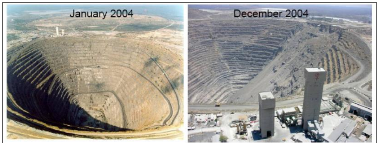
Figura 2-2: Mina Palabora Antes y Después de Falla en Pared del Rajo (Ngidi and Boshoff, 2007).
