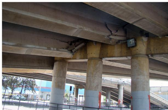
Figura 2-39. Puente Miraflores, Vespucio Norte; (a) Situación posterior al terremoto de Maule (2010); (b) Reparaciones de estructura, que incorporaron extensores de apoyo, topes sísmicos de hormigón armado y diafragmas
