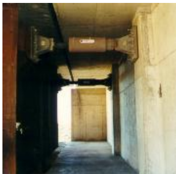
Figura 2-38. Disipadores viscosos en Puente Amolana
