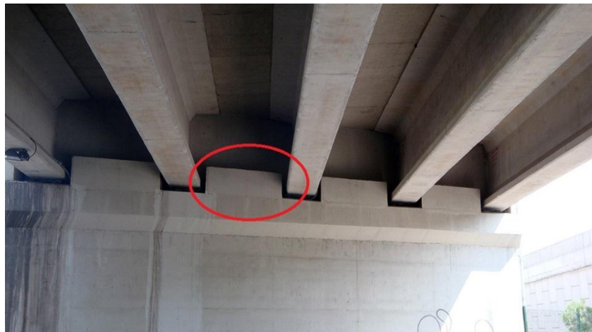
Figura 2-9. Tope sísmico de hormigón armado en estribo
