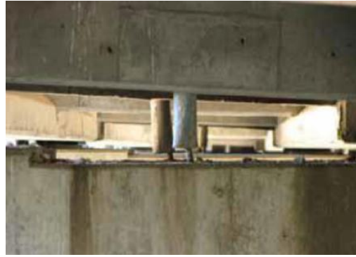
Figura 2-17. Dispositivo de disipación metálico
