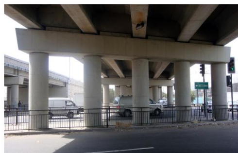
Figura 2-39. Puente Miraflores, Vespucio Norte; (a) Situación posterior al terremoto de Maule (2010); (b) Reparaciones de estructura, que incorporaron extensores de apoyo, topes sísmicos de hormigón armado y diafragmas
