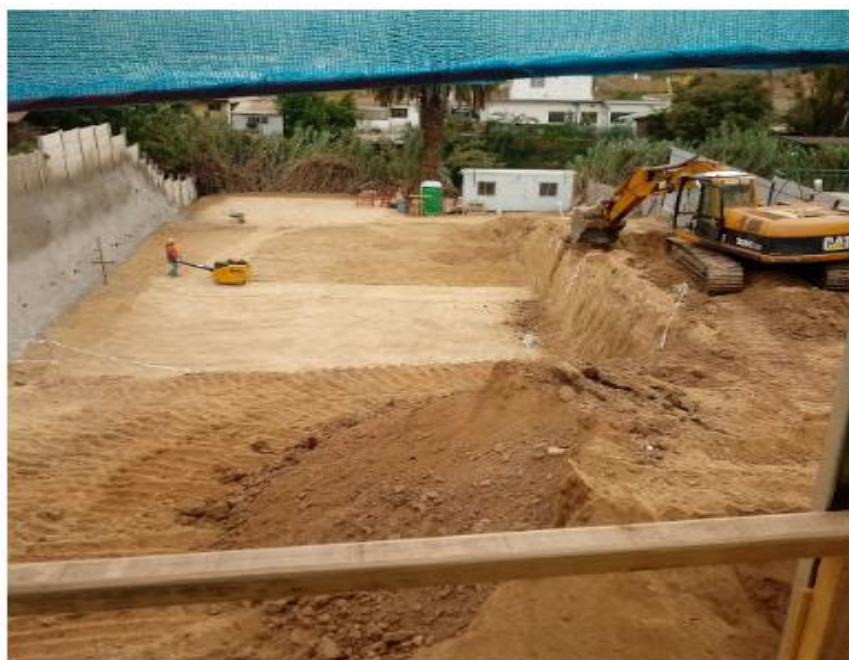
Fuente: Registro Propio a obra París, octubre 2018
