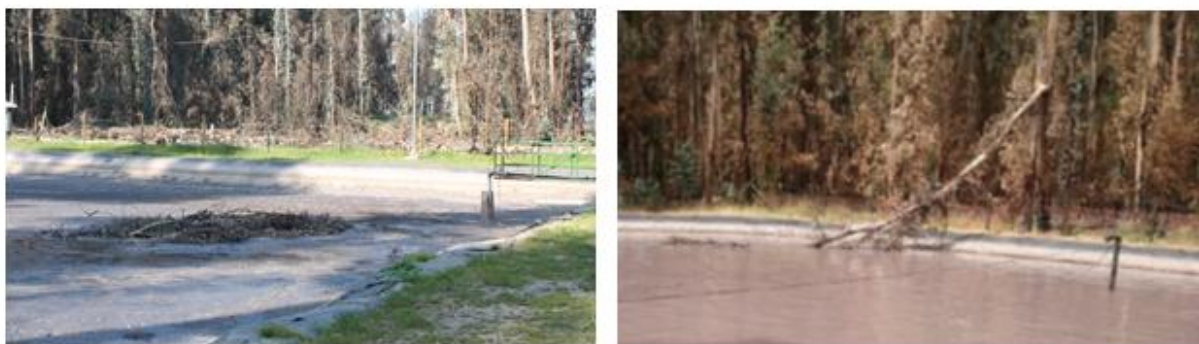
Ilustración 14 : Acumulación de residuos en las piscinas del tratamiento
