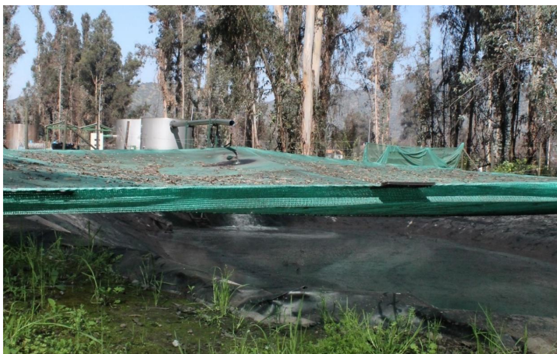
Ilustración 30 : Piscina de riego con malla
