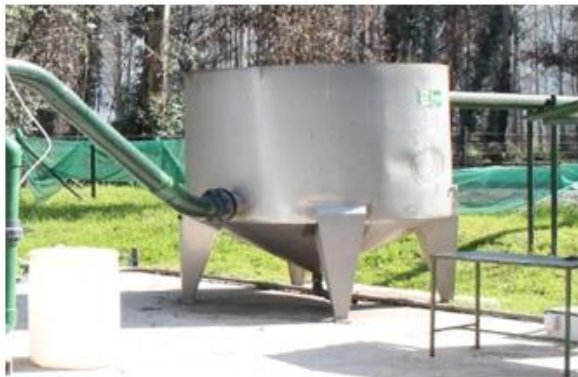
Ilustración 18 : Estanque de desinfección
