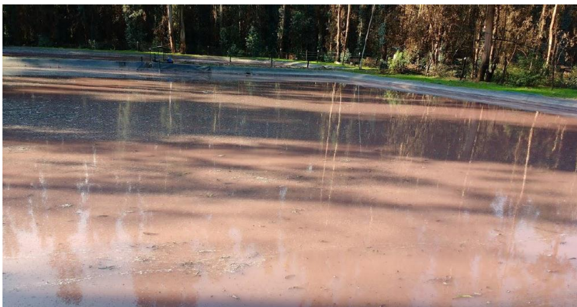
Ilustración 15 : Estado piscina de ecualización
