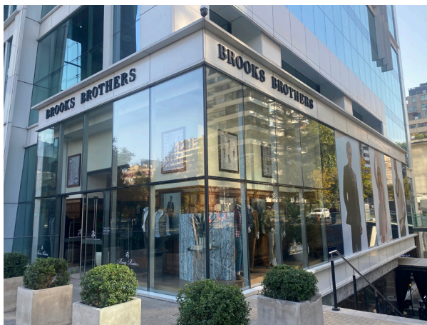
Figura 48 Fotografía exterior, caso 1
