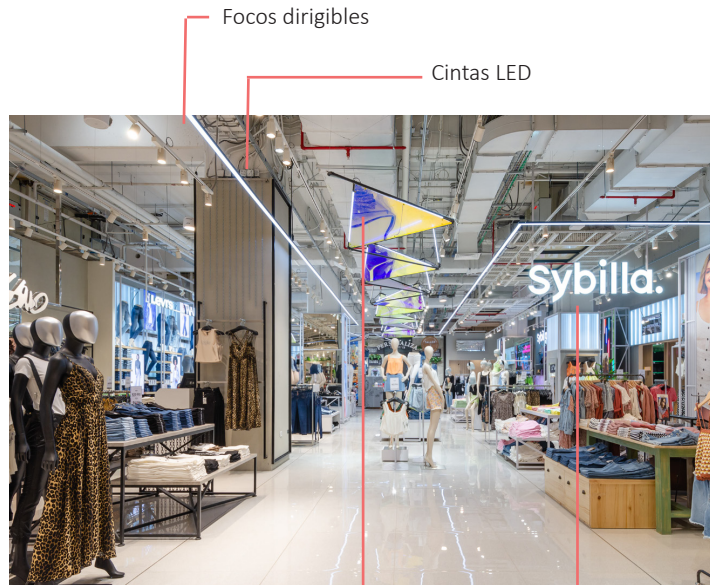
Figura 83 Luminarias en el interior
