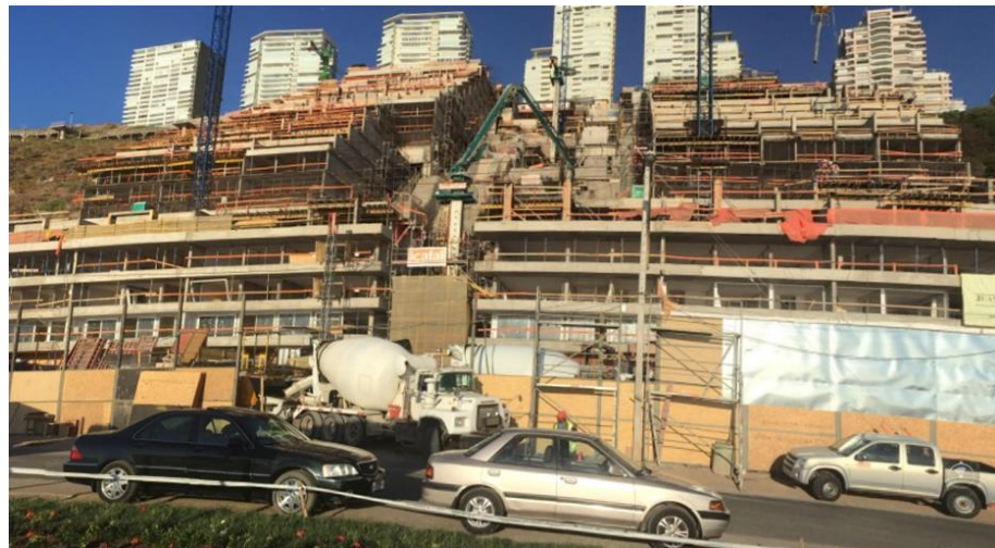
Fuente: Fotografía tomada en obra “Terrazas de Cochoa”
