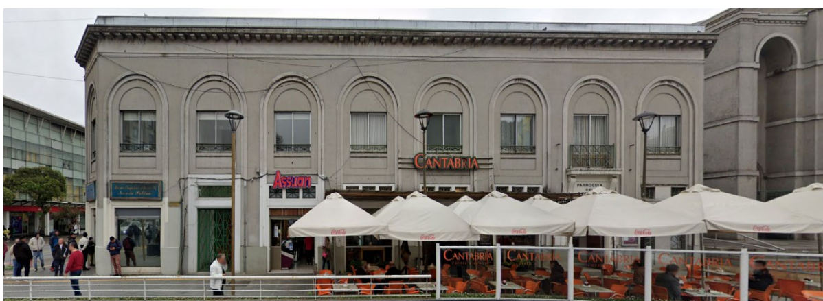
Ilustración 1: Edificio seleccionado, Caupolicán 415
