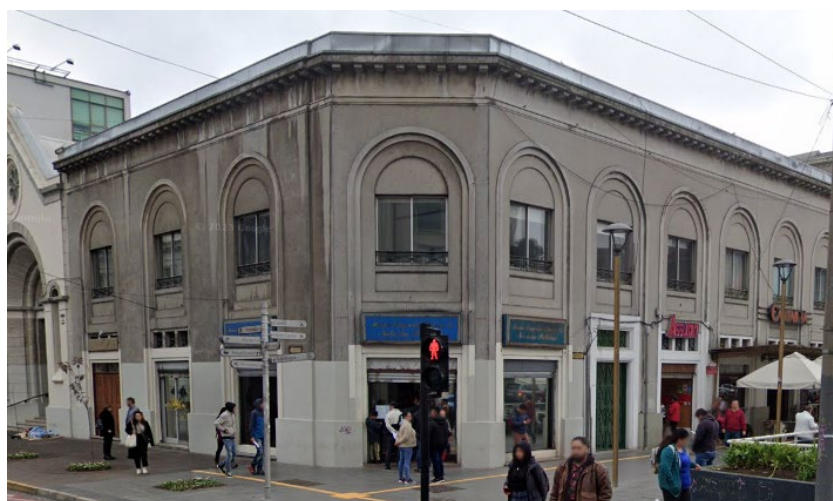
Ilustración 2: Edificio seleccionado, esquina O'Higgins - Caupolicán
