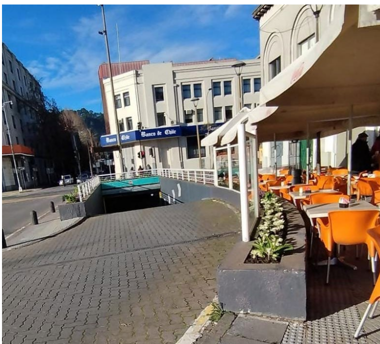
Ilustración 3: Estacionamiento Saba Catedral Concepción
