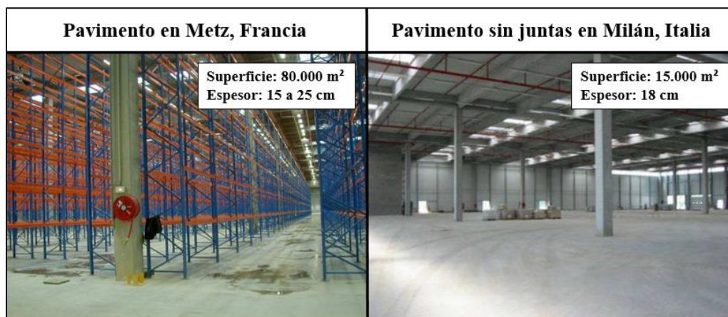
Figura 2.45. Aplicaciones de pavimentos de hormigón reforzado con fibras en Europa.
