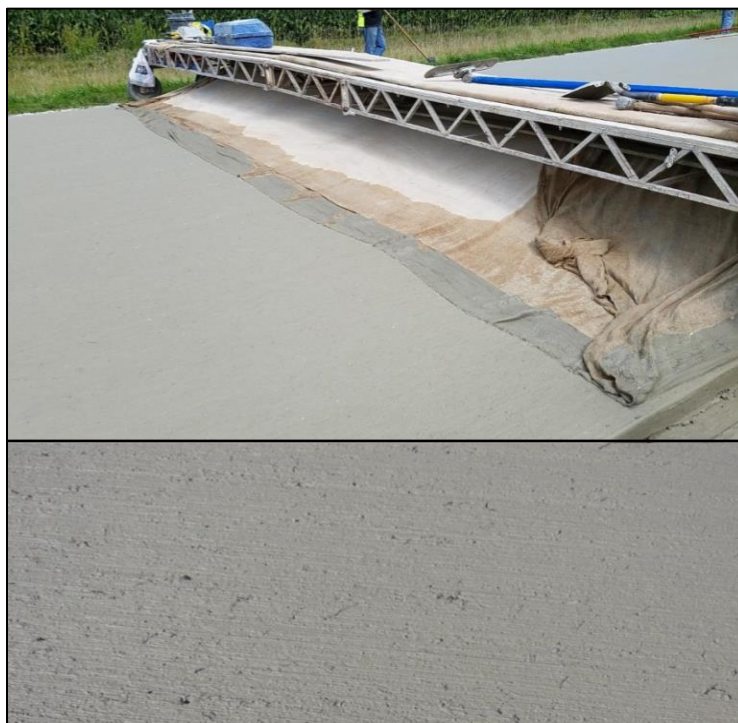
Figura 2.10. Texturizado con capa de arpillera de un pavimento de hormigón reforzado con 2,4 kg/m 3 de fibra sintética.
