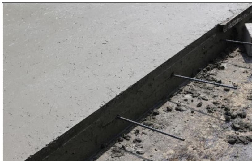
Figura 2.9. Ejemplo de apariencia de superficie de un pavimento de HRF.
