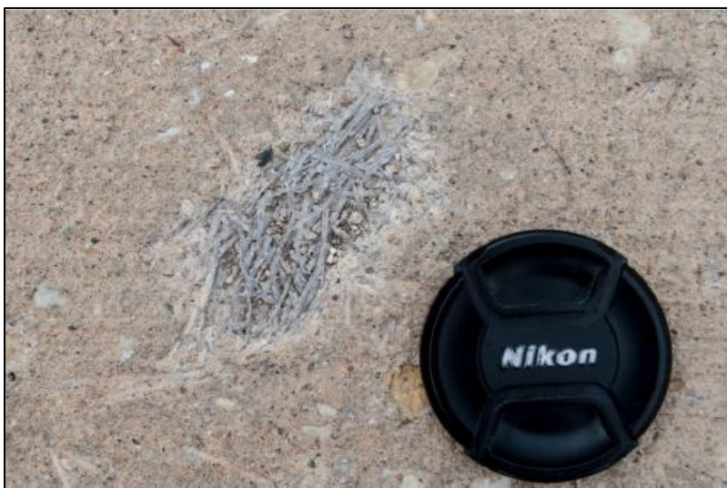
Figura 2.2. Ejemplo de Apelotonamiento de fibras en pavimento de HRF.
