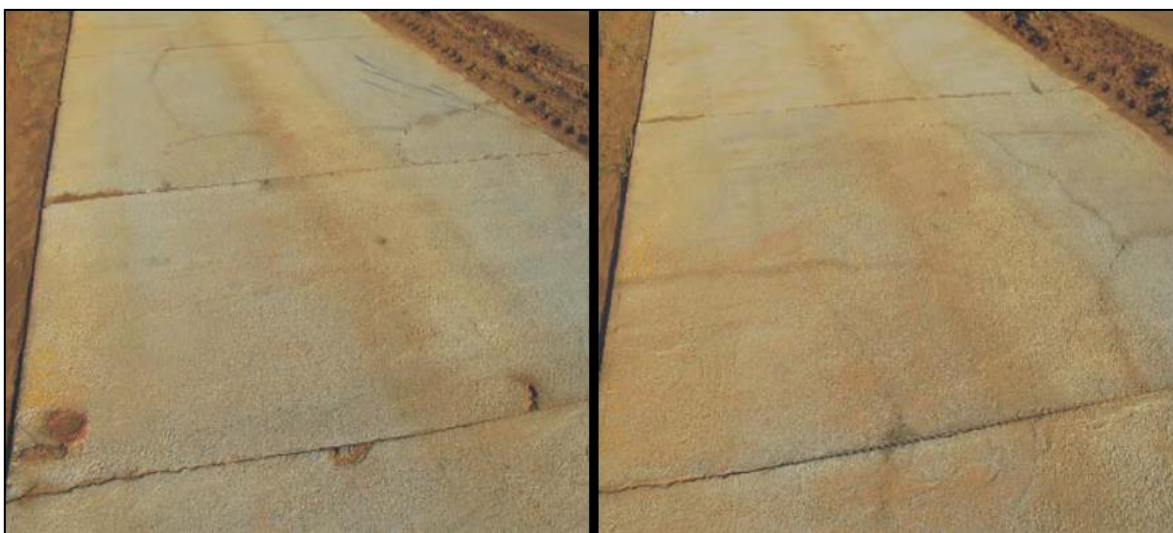
Figura 2.39. Situación final para las losas de la sección #7 (sin fibra).
