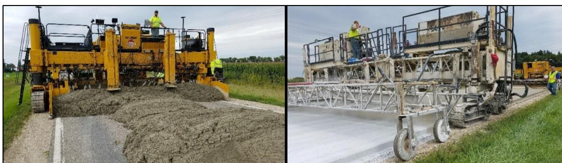
Figura 2.7. Ejemplo de construcción de pavimento de hormigón con fibra en Iowa.
