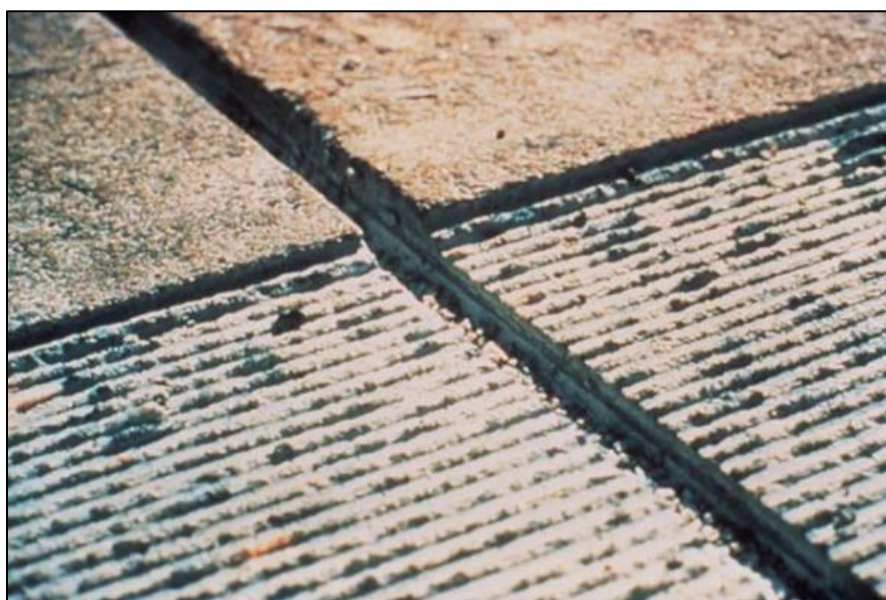
Figura 2.12. Técnica de rectificado de diamantes para un pavimento de hormigón.
