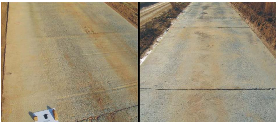
Figura 2.38. Situación final para las losas de la sección #2 (con fibra).
