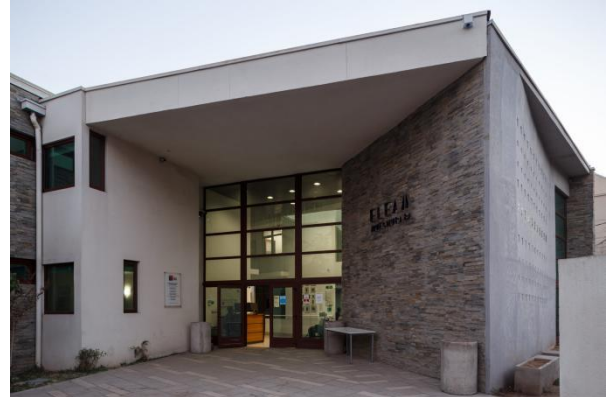
Image 9: Fachada ELEAM Huechuraba.
