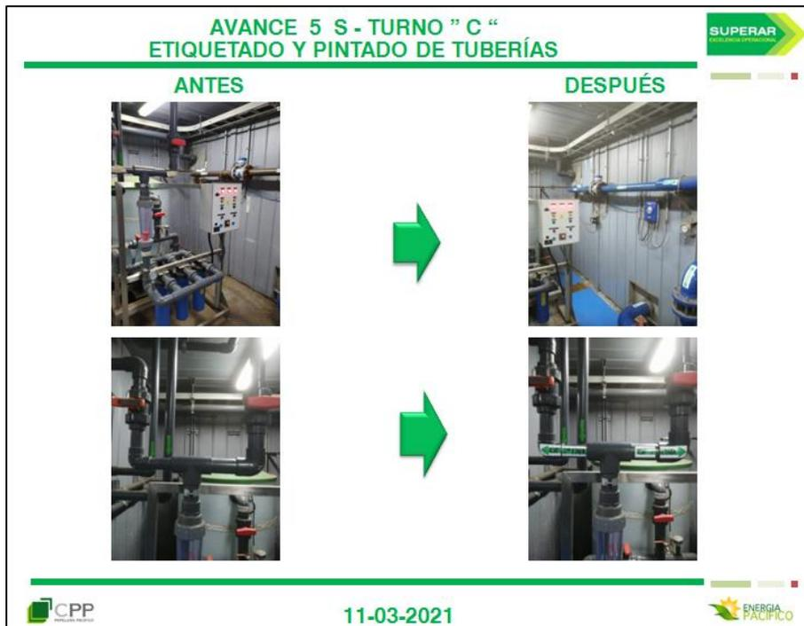
*Figura 7.7: Mejora 5S de pintado y etiquetado de tuberías.*
