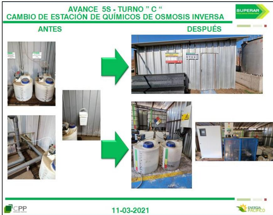
Figura 7.12: Mejora 5S de cambio de estación de químicos, a un galpón fuera de la planta por razones de seguridad.
