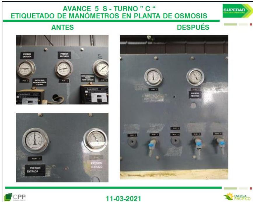
*Figura 7.4: Mejora 5S de rotulado de etiquetado de manómetros de la osmosis inversa.*
