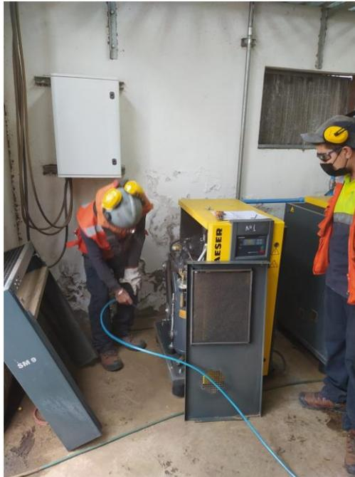
*Figura 7.18: Trabajadores aprenden a limpiar el conjunto interno del compresor para evitar fallas por falta de limpieza.*
