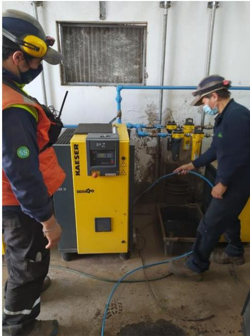
*Figura 7.16: Operador limpiando el ventilador del compresor con aire comprimido.*
