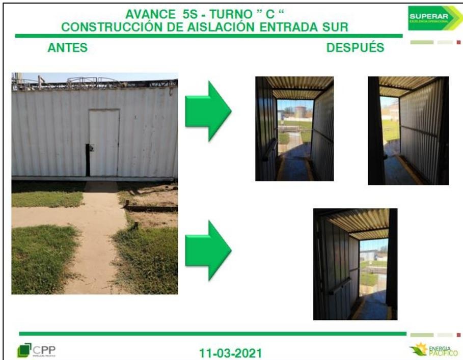
*Figura 7.11: Mejora 5S de entrada lado sur a la planta de osmosis inversa, para disminuir el ingreso de polución.*
