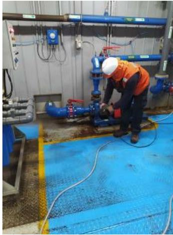
*Figura 7.24: Limpieza inicial de la estación de retrolavado de la osmosis inversa.*
