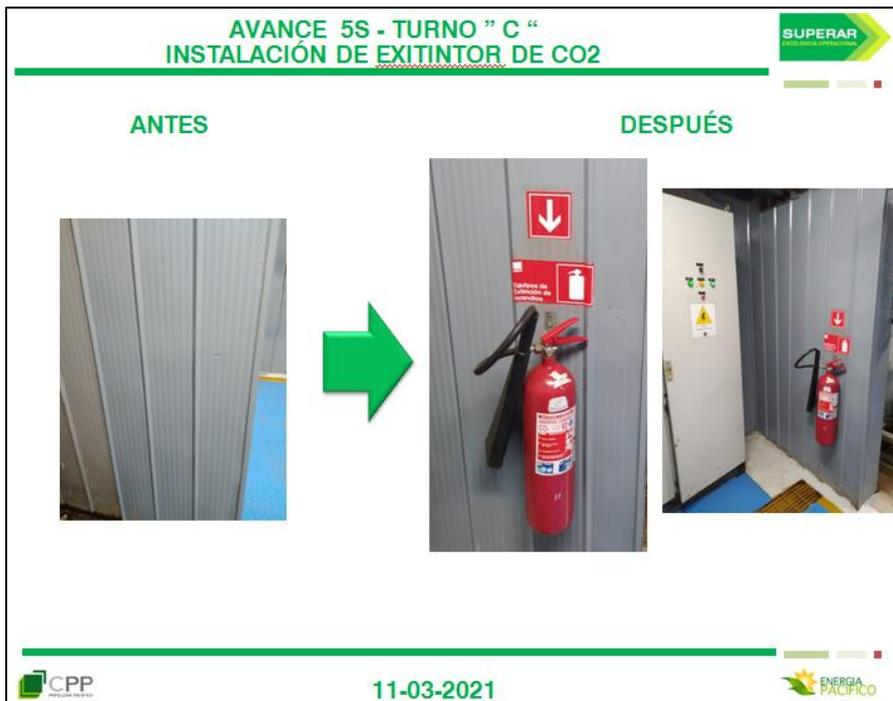
*Figura 7.3: Mejora 5S de instalación de extintor de CO2 para panel eléctrico.*
