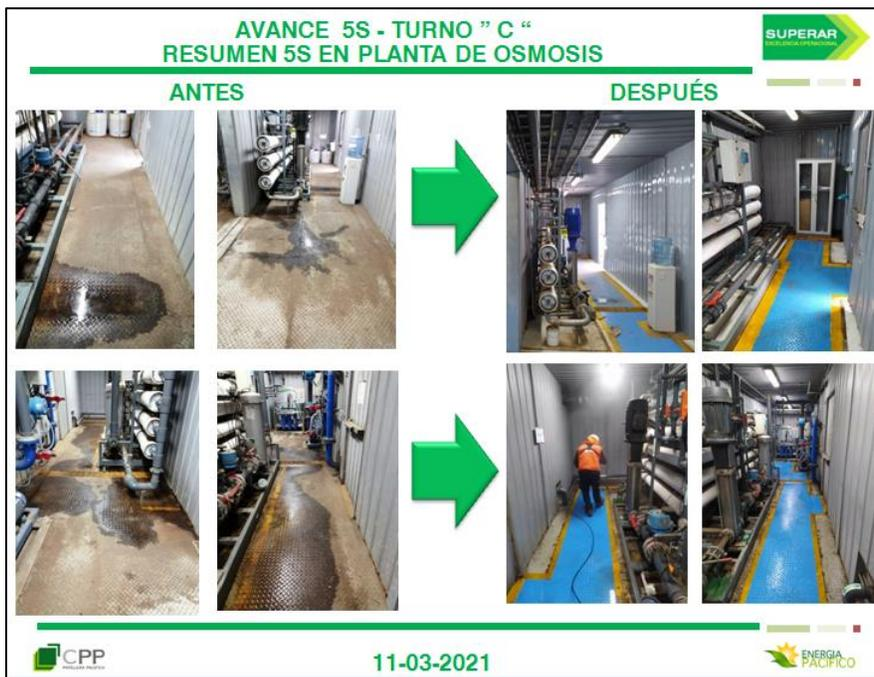
Figura 7.13: Resultado general de la implementación de la metodología 5S en la planta de osmosis inversa.
