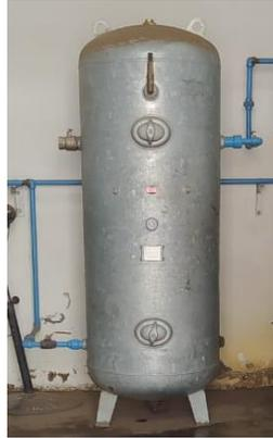
*Figura 4.23: Acumulador emplazado en una sala de compresores de una central de cogeneración*
