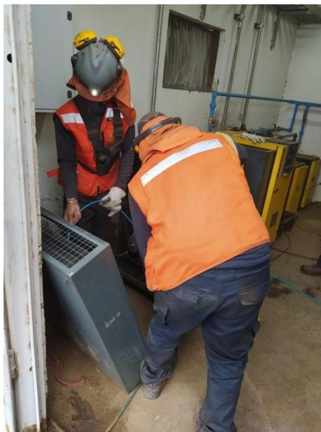
*Figura 7.19: Operadores limpian tapas de compresores además del conjunto interno.*
