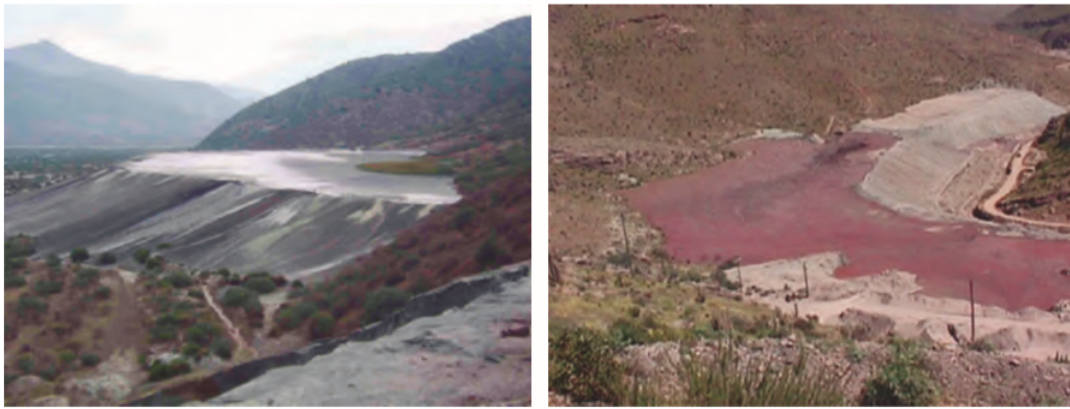
Figura 2.4: Nivel excesivo de laguna de aguas claras.
