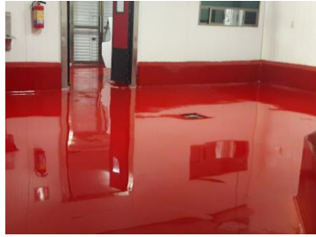
Figura 2-13. Trabajo de Pintura esmalte epóxico
