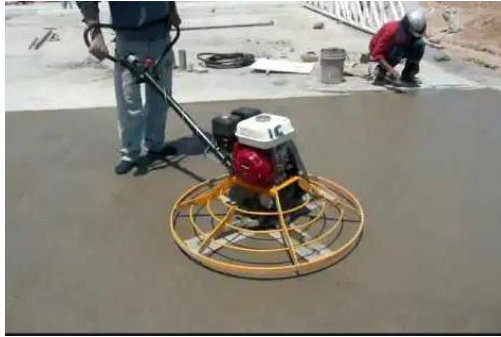
Figura 2-7. Trabajo de allanada tipo “helicóptero”
