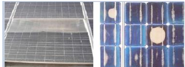
Figura 1.24 Delaminación severa en módulos [40].
