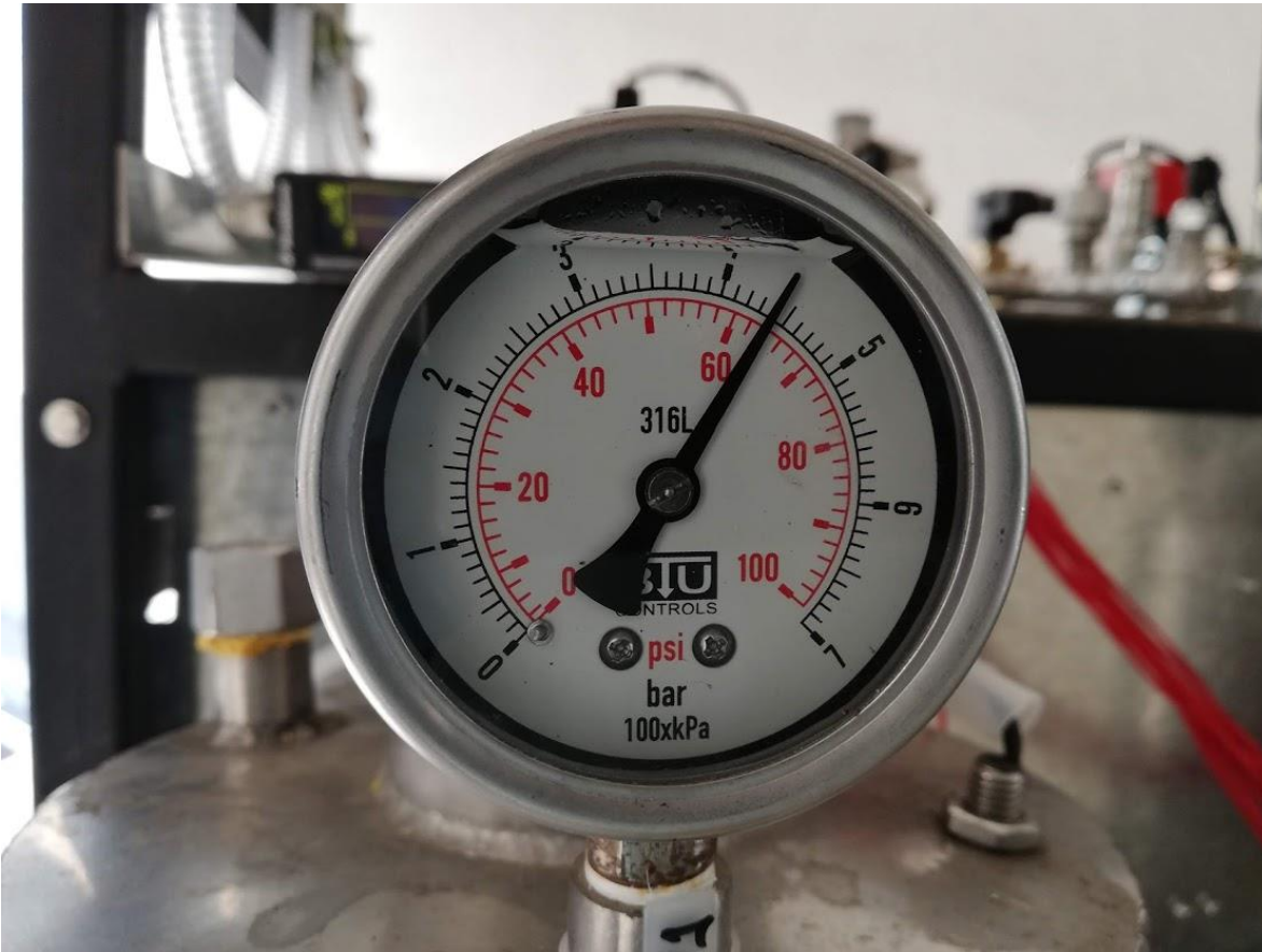
Figura 74: Presión máxima alcanzada en pruebas de presión con celda completa.
