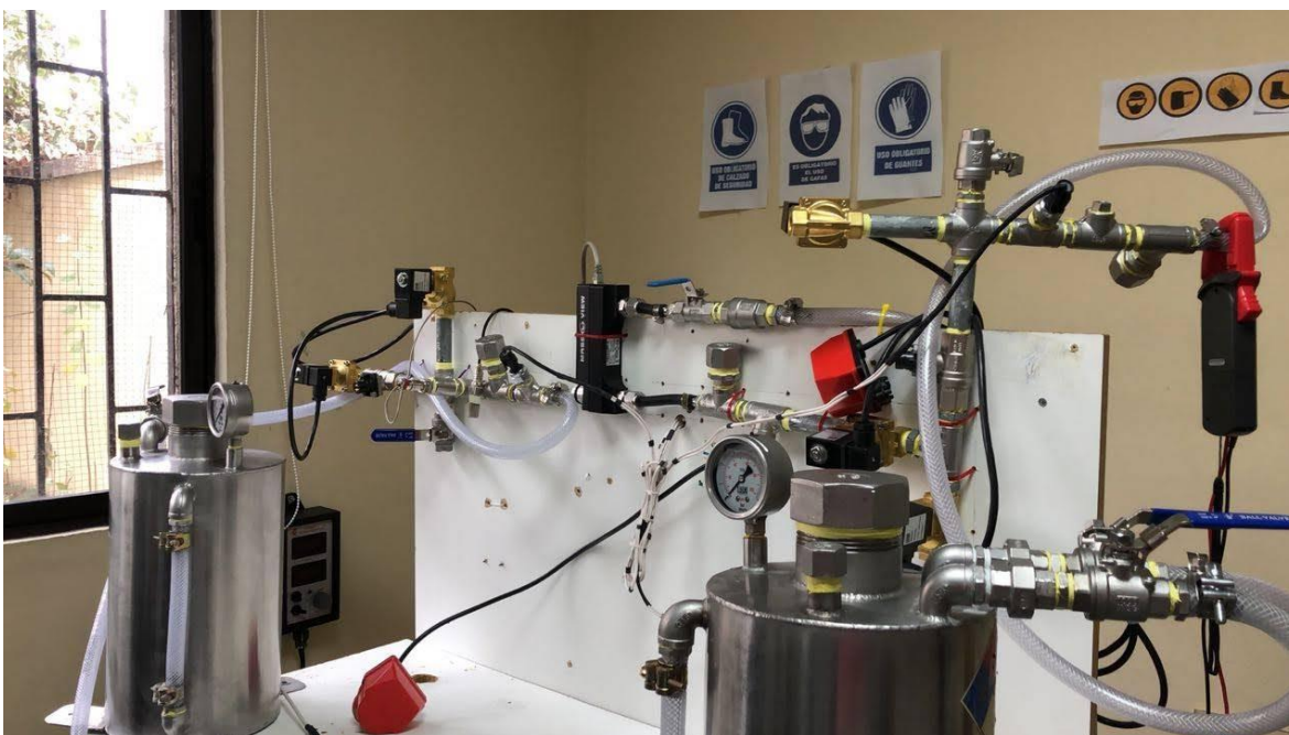
Figura 73: Prueba de presión en líneas de control.
