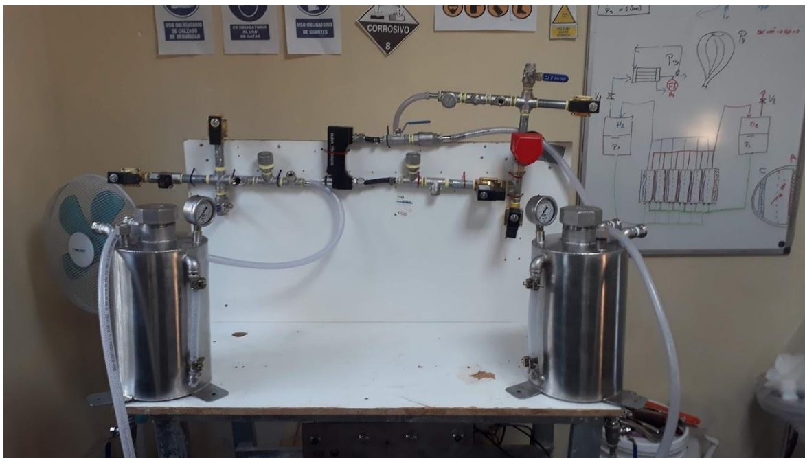
Figura 72: Prueba del sistema de control de hidrógeno y oxígeno a nivel de estanques.
