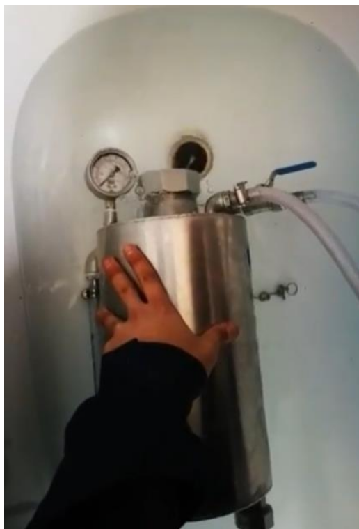
Figura 65: Verificación de fugas con presión mínima en estanques de acumulación.
