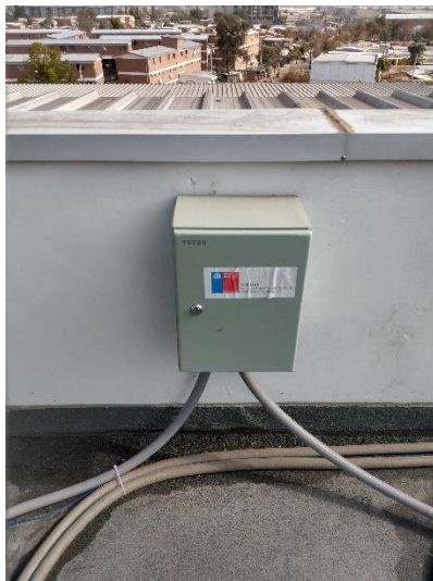
Figura 3.70: Se instala una caja metálica al oeste de la azotea, destinada sólo a proteger un registrador de datos CR1000X, el cual se encuentra almacenando información de los sensores de temperatura.
