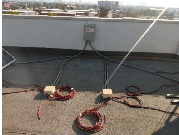
Figura 3.74: Canalización eléctrica mediante tubos flexibles metálicos, reemplazando las canaletas (Figura 3.60).
