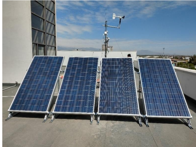
Figura 3.55: Instalación de módulos FV policristalinos, estructuras paneles y estación meteorológica.
