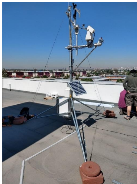
Figura 3.56: Instalación preliminar estación meteorológica RSR100.
