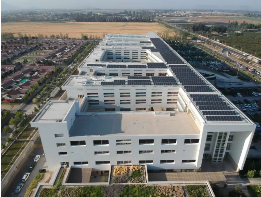
Figura 3.5: Instalación fotovoltaica del Hospital Regional de Rancagua - Programa Techos Solares Públicos.
