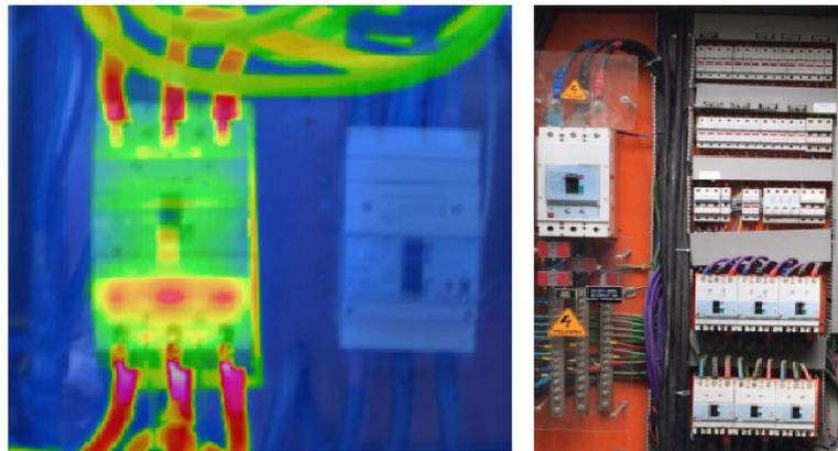
**Figura 3.4:** Análisis termográfico a equipos de conexión eléctrica.
