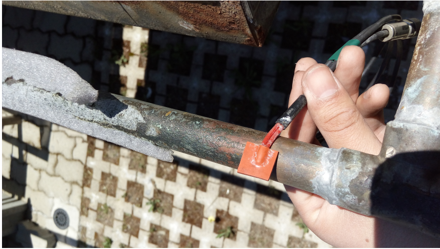
Figura 4.17: Estado de la instalación de los sensores de temperatura de contacto.
