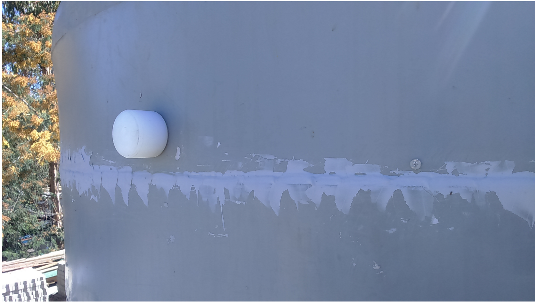
Figura 4.3: Pernos fabricados en Technyl poliamida para el cierre del humidificador.
