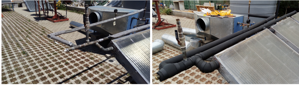
(a) Cañería de agua caliente en voladizo. (b) Modificación de geometría de cañería.
