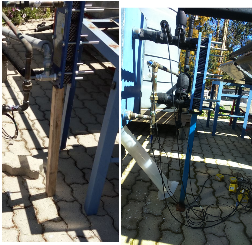
(a) Trozo de madera utilizado como soporte. (b) Soporte nuevo fabricado en metal.
