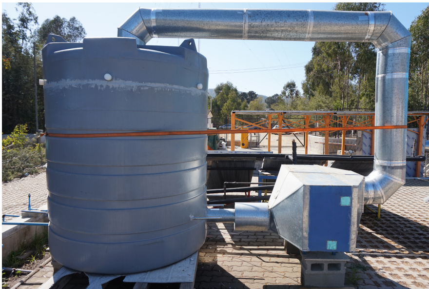
Figura 4.12: Pceso de reparación de los ductos de aire.
