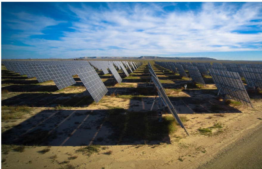
Figura 4.1: Instalación de seguidores de la empresa Sun Action. Fuente: Sun Action.
