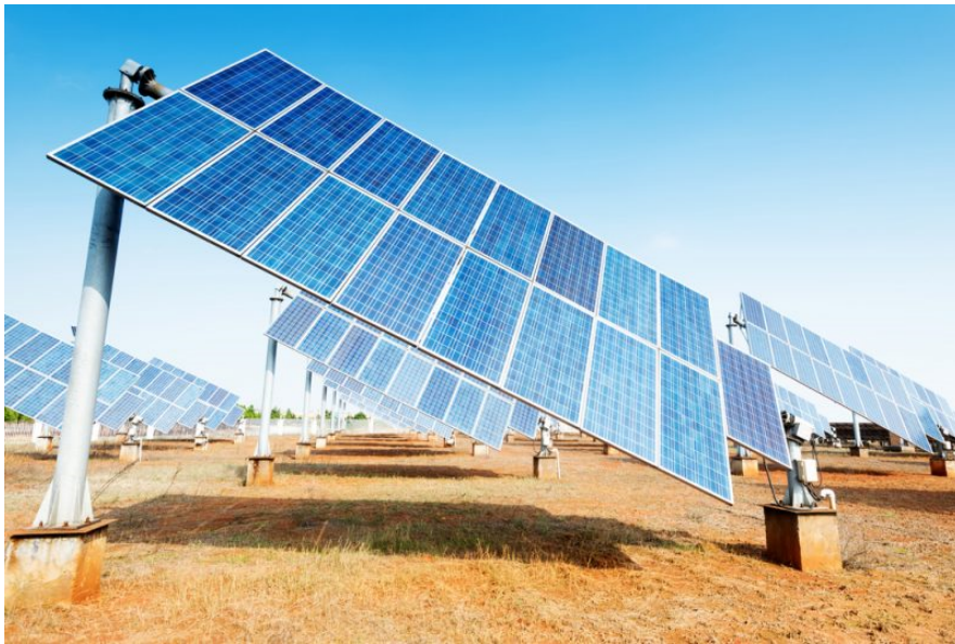
Figura 2.5: Seguidor solar de un eje Inclinado. Fuente: Salix Solar.
