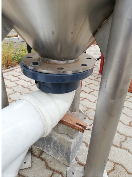
Figura 4.9: Conexión con manguito y anillo elastomérico en el humidificador.
