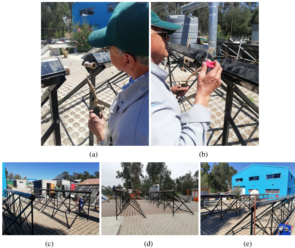
Figura 4.3: Construcción del piping para colectores.
