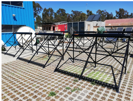
Figura 4.2: Armado de estructuras soporte para tubos Heat Pipe.
