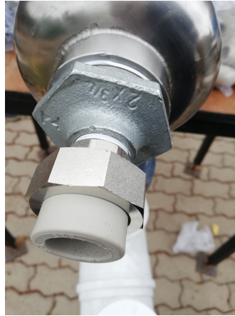
Figura 4.15: Unión americana utilizada en la instalación del circuito de agua salada.
