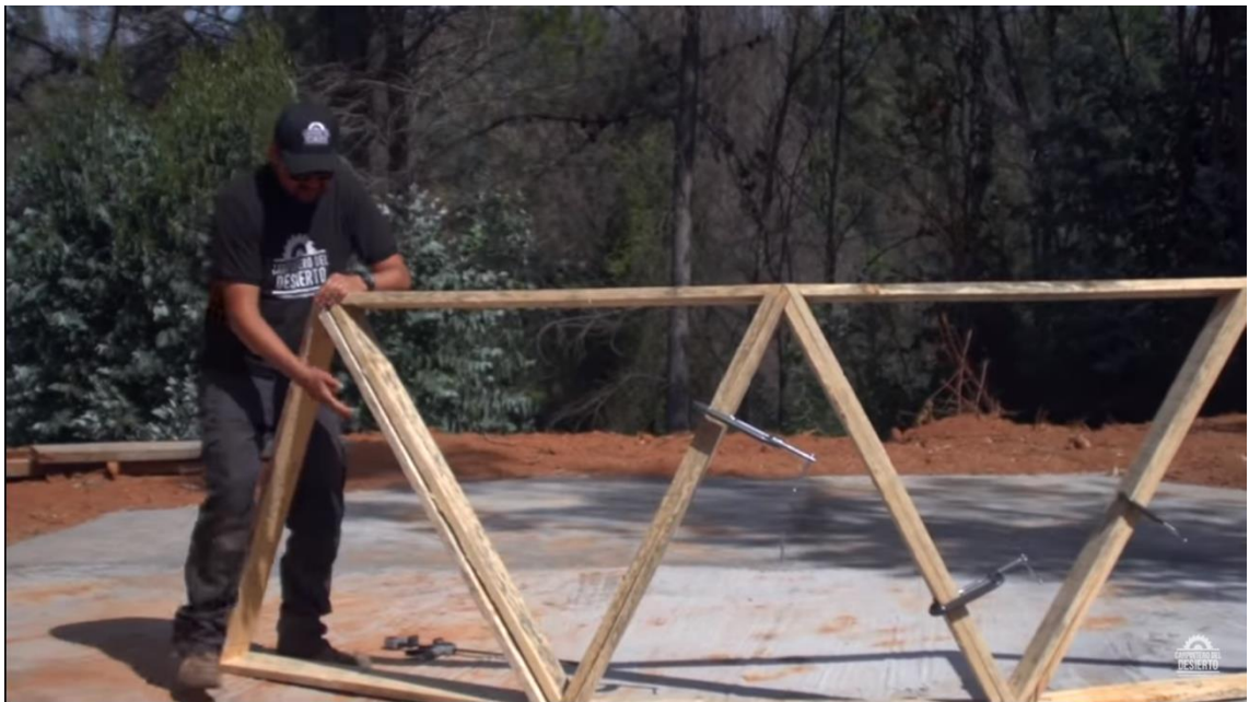
Ilustración 12 Armado de triángulos
