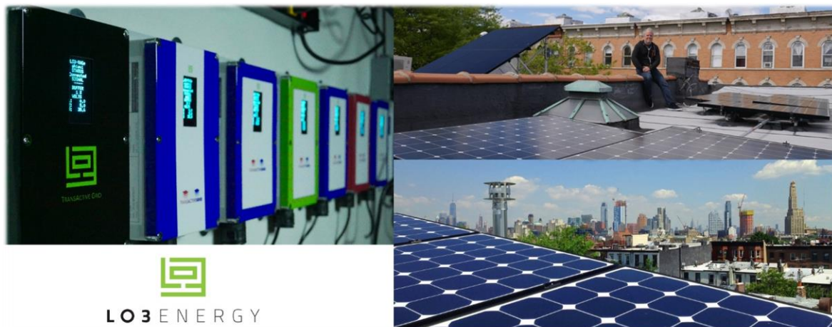
Figura 2.6: Microgrid ubicada en “President Street”, NY. El proyecto pretende crear un pool de energía entre prosumidores y consumidores, con el fin de que cada uno elija a su proveedor dentro de una red local [34].
