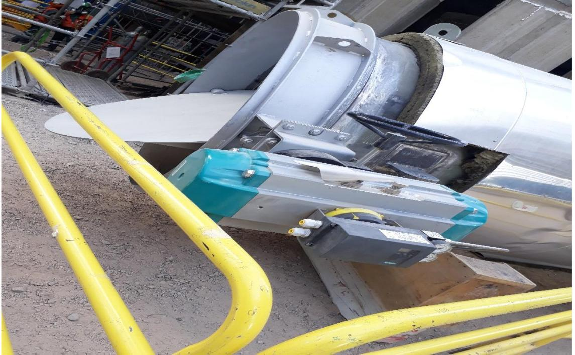
Figura 2-17 Levantamiento Línea 4020, Ducto con DUMPER finalizado
