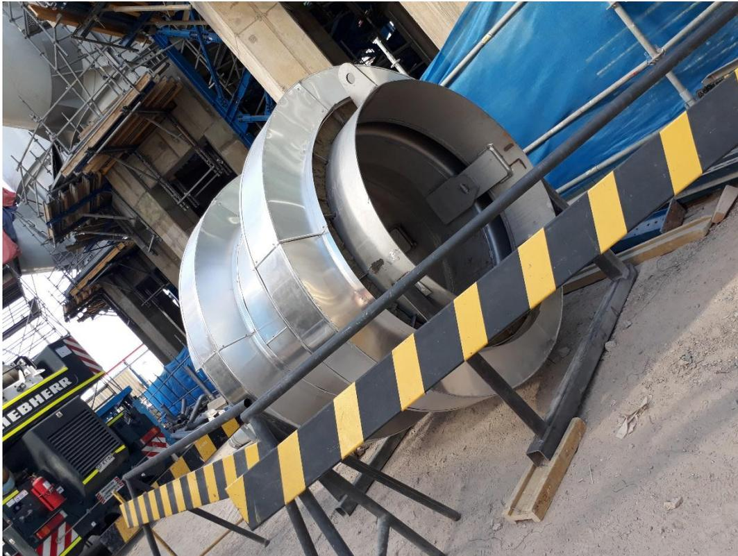
Figura 2-12. Levantamiento Línea 4014, Ducto con junta de expansión
