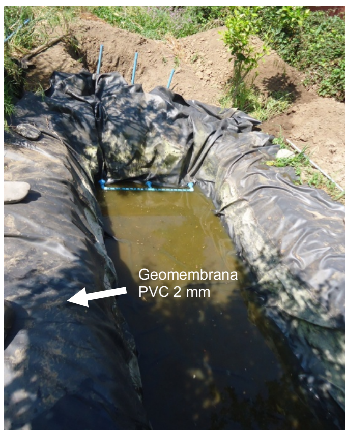
Figura 11. Impermeabilización humedal artificial
