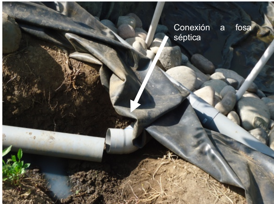
Figura 12. Instalación entrada desde fosa séptica
