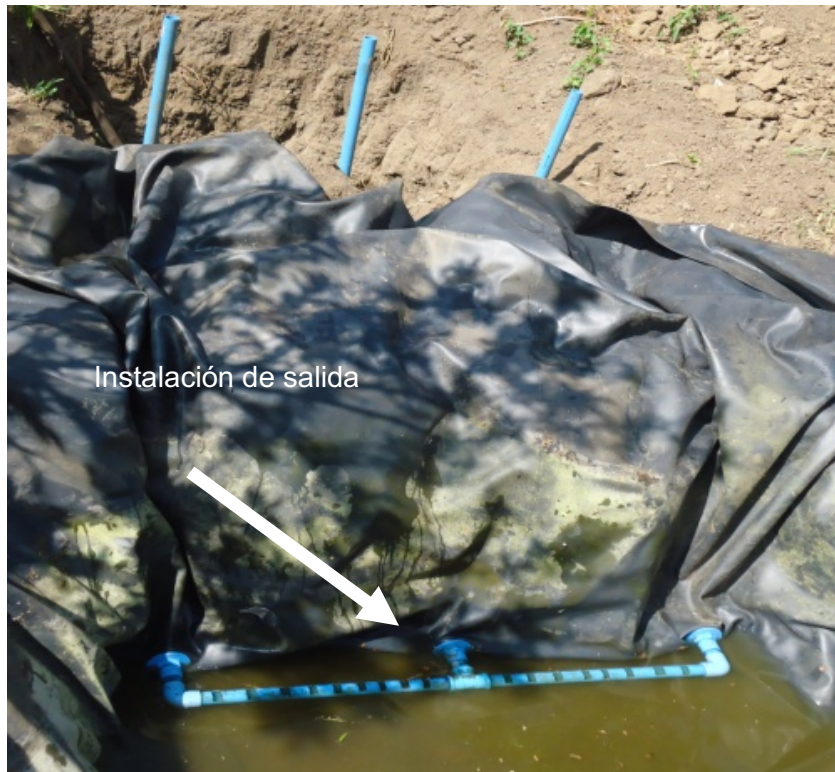
Figura 14. Instalación salida de aguas tratadas.
