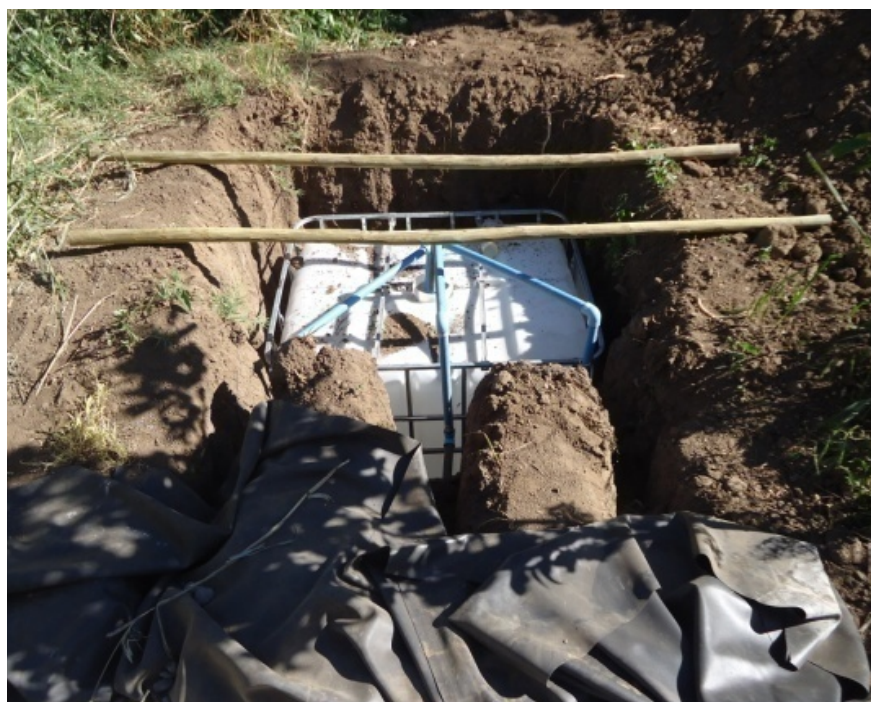
Figura 20. Construcción sistema de almacenaje agua tratada. Fuente: Elaboración propia
