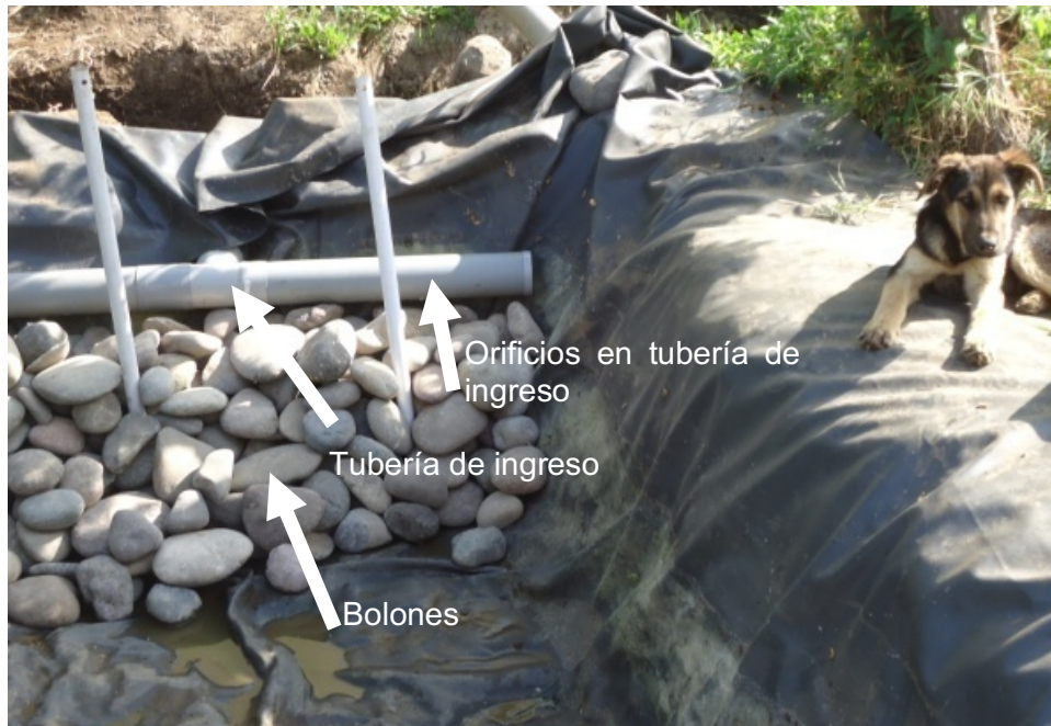
Figura 13. Instalación entrada de aguas contaminadas.
