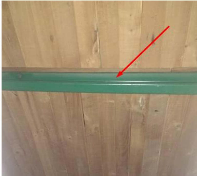
Imagen 3-3. Foto viga y entablado de techumbre existente.
