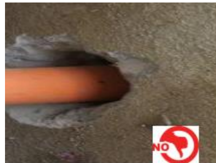
Imagen 3-19. Deficiente aislación.
