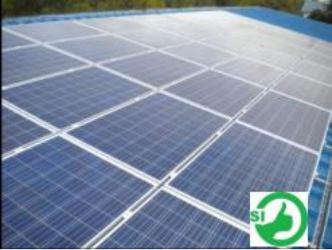
Imagen 3-11. Correcto alineamiento de los paneles fv.
