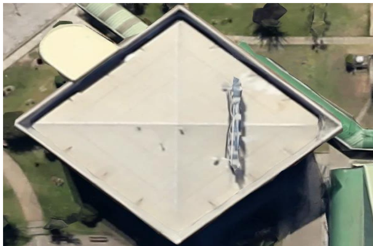
Imagen 3-2. Foto satelital de la cubierta existente.
