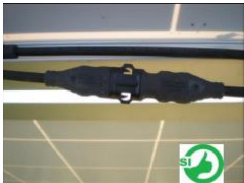
Imagen 3-15. Correcta conexión
