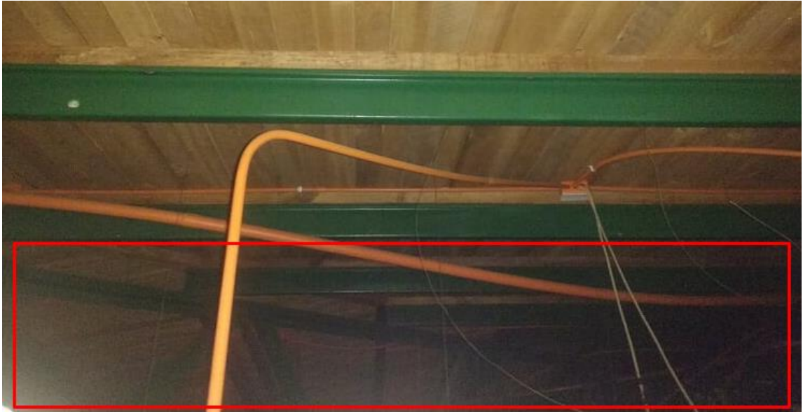
Imagen 3-4. Foto cerchas existente.
