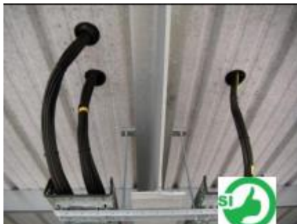
Imagen 3-18. Correcta aislación
