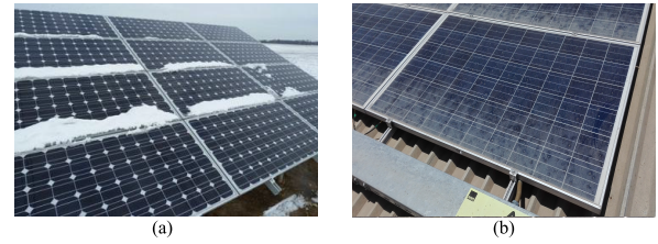
Fig. 2. Ejemplos de sombreado parcial a largo plazo. (a) Acumulación de nieve - (b) Acumulación de polvo
