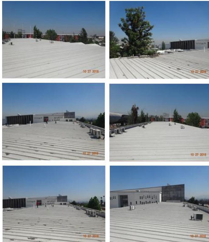
Figura 3.5: Fotografías techo edificio A.-
