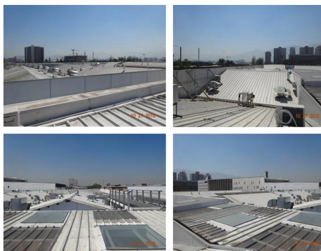
Figura 3.3: Fotografías techo edificio B.-
