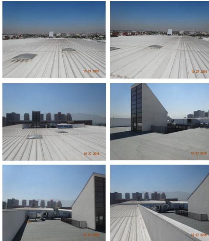
Figura 3.4: Fotografías techo edificio F.-
