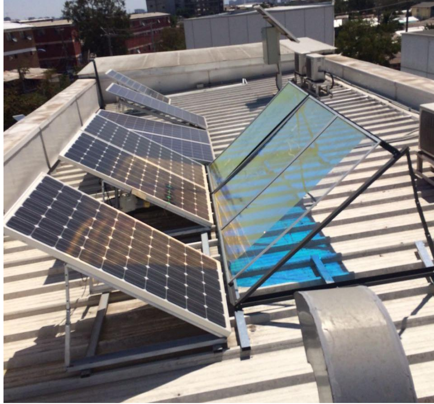
Figura 45: Efecto visual del reflector para un día soleado
