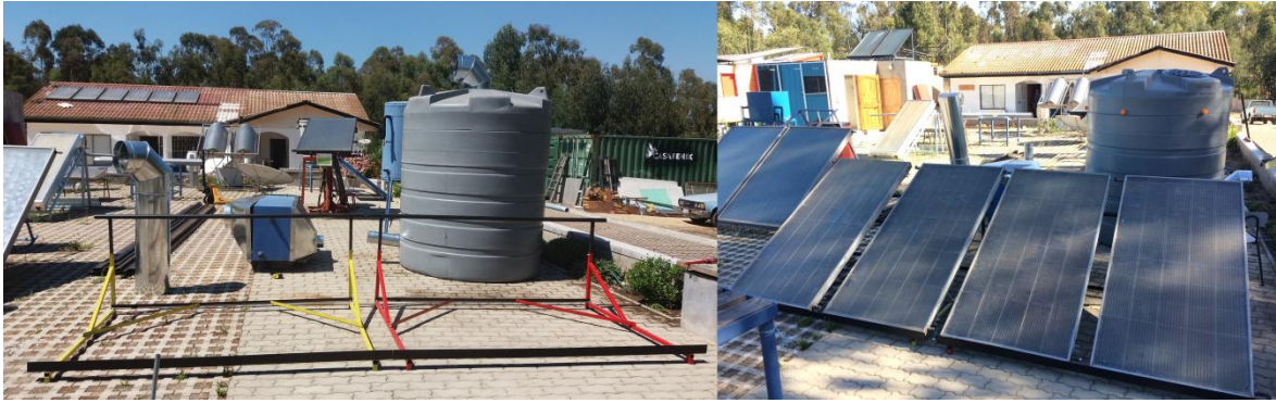
Figura 4-11. Instalación de los colectores solares.
