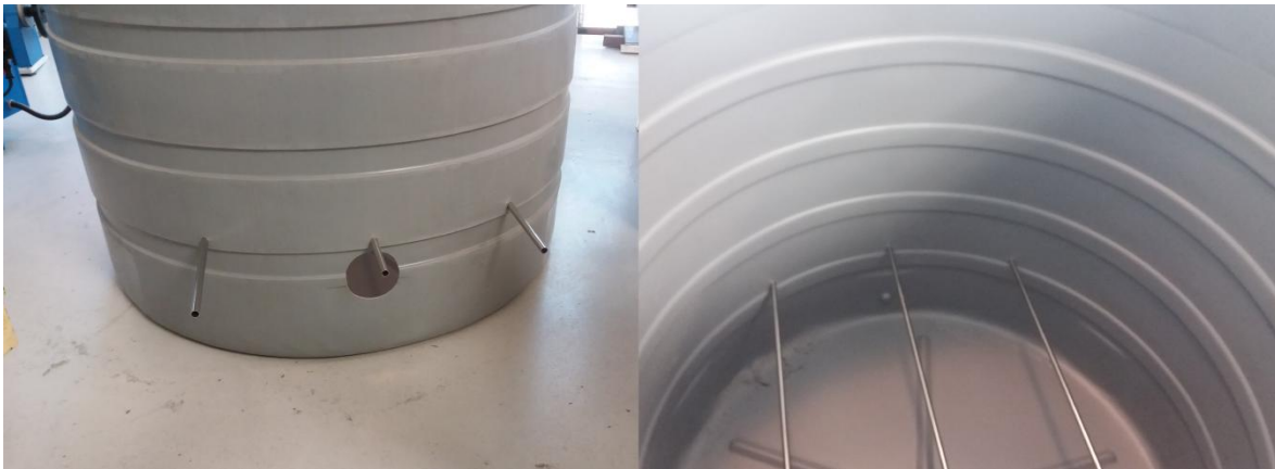
Figura 4-4. . Instalación de los sujetadores del relleno y orificio para la instalación del ducto de 6”.
