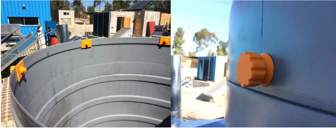
Figura 4-5. Instalación de la tapa del humidificador.
