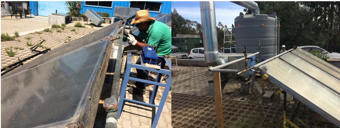
Figura 4-12. Conexión de los colectores solares.
